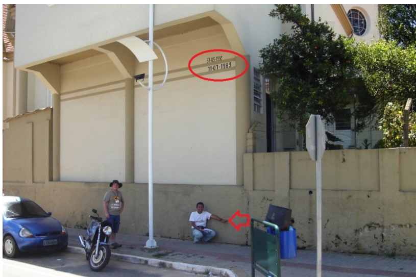
Figura 2 – Marcas das inundações no centro de Rio Negrinho. Em destaque, marcas de 1983 e 1992; a seta indica a altura que a água atingira no dia 13/01/2010.
