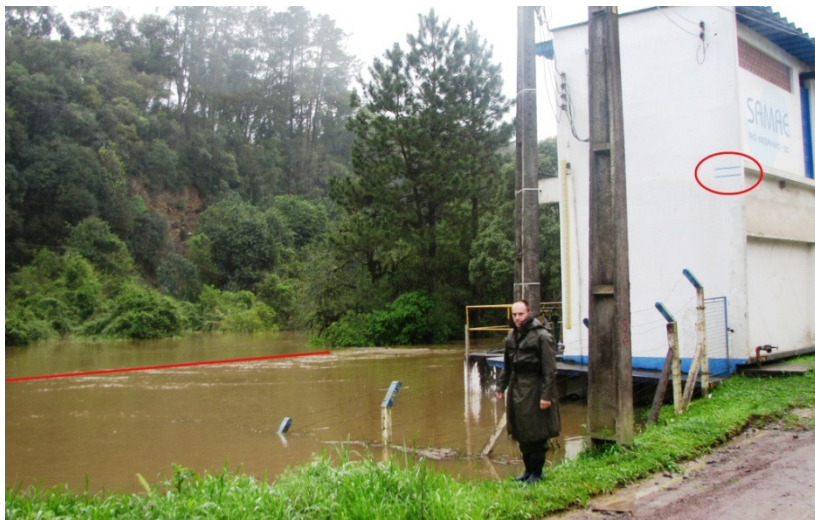
Figura 1 – Inundação em setembro de 2009, na captação da SAMAERN no Rio Negrinho. Em destaque, as marcas das inundações de 1992 (acima) e 1983 (abaixo). A linha vermelha representa a margem esquerda do rio em condições normais.
