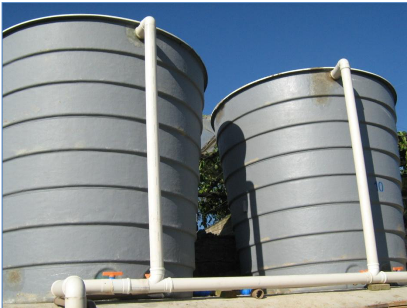
Figura 15: Reservatórios de Estabilização R1 e R2
