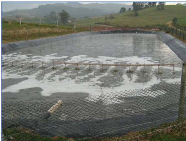
Figura 3: A Lagoa Facultativa aerada.
