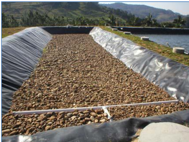
Figura 5: Filtro de pedras (escala real)
