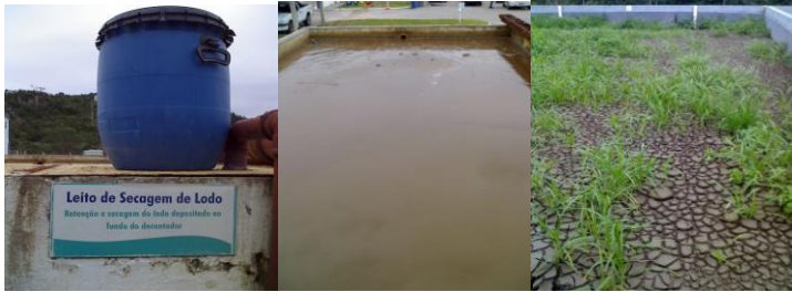
Figura 5 - Bombonas de 60 L para Coleta de Lodo e Leitos de secagem de lodo da ETE e ETA
