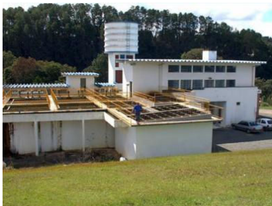
Figura 7 – Estação de Tratamento de Água 1 – SAMAE
