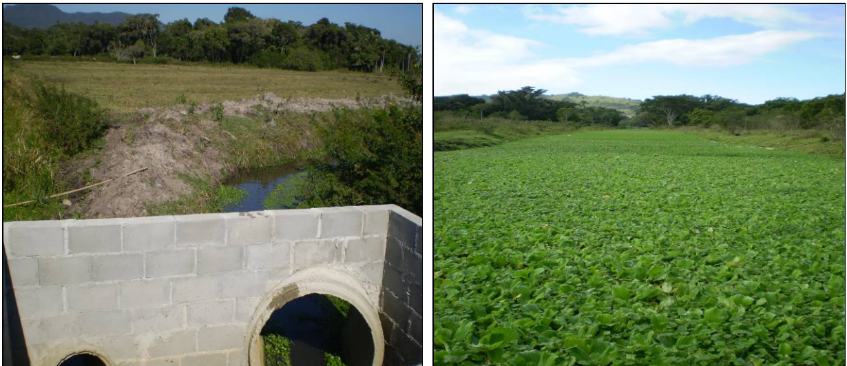
Figura 18 - Ponto P20 e o canal com excesso de macrófitas entre esse ponto e o P19
