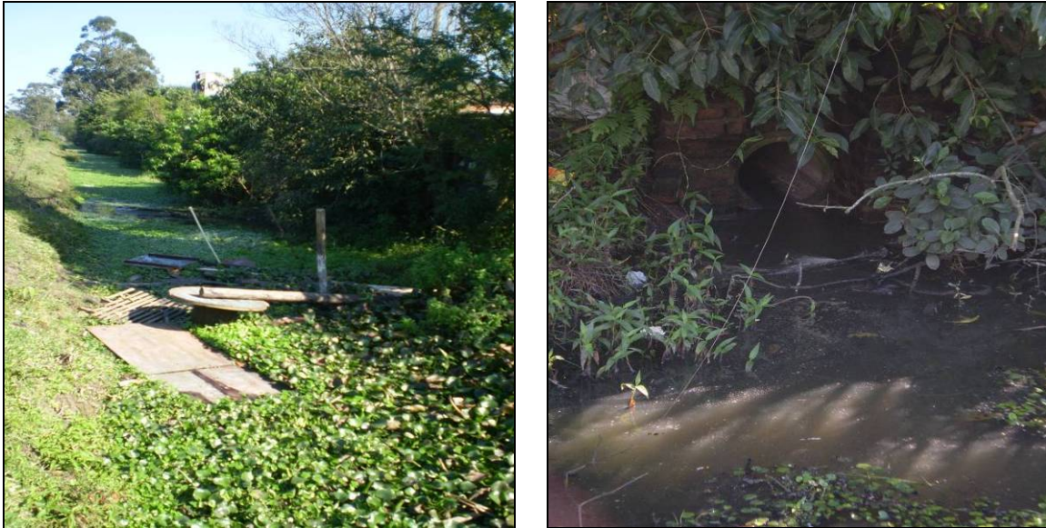
Figura 20 - Canal onde localiza-se o P10 e lançamento irregular de esgoto doméstico no canal
