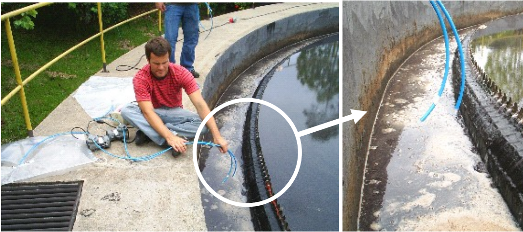
Figura 4.7: Amostragem no ponto 5 – Decantador Secundário
