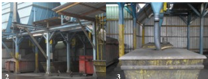
Figura 17- (1) Resíduo de Areia de Macharia. (2) Exaustores. (3) Resíduo de Pó de Exaustão.
