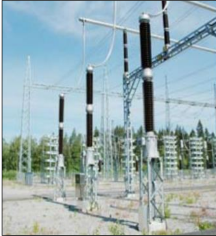
Figura 3.4 - Transformador de potencial capacitivo. Fonte: (ABB, 2009)
