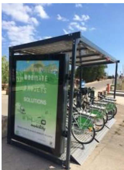
Figura 1.5 - Posto de carregamento de bicicletas por energia solar [7]
