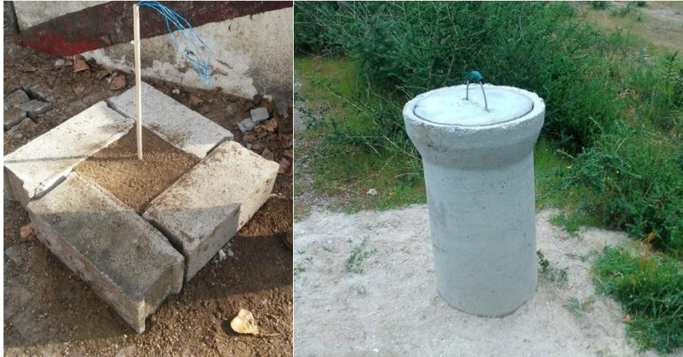
Figura 4.1 - Fotografias da intervenção realizada junto a uma sonda de monitorização da temperatura. À esquerda: antes da intervenção. À direita: depois da intervenção
