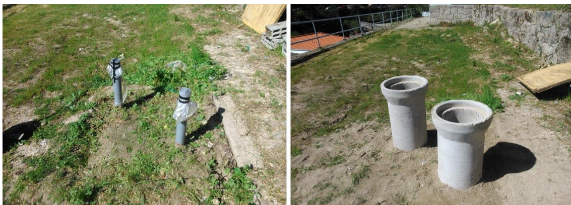
Figura 4.2 - Fotografias da intervenção realizada no local do permutador de calor ar-solo. À esquerda: estado inicial. À direita: depois da intervenção
