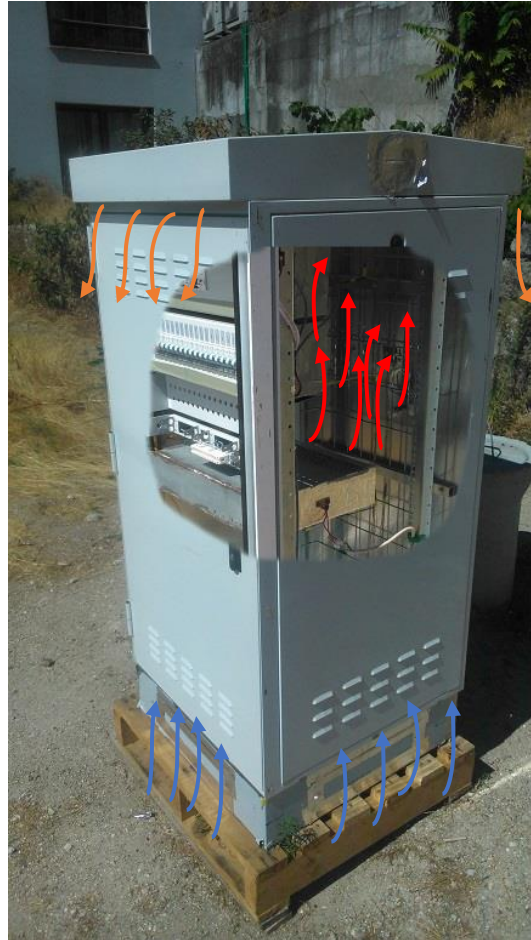
Figura 5.6 - Esquema da ventilação do armário com os ventiladores embutidos
