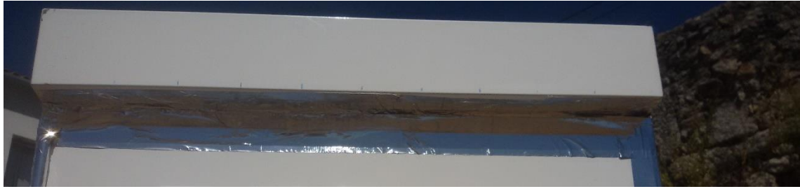
Figura 4.28 - Ranhuras da cobertura vedadas.
