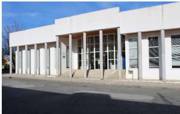
Figura 4.32: Entrada principal da Biblioteca Municipal de Alfândega da Fé. Fonte: Catarina Pinto.
