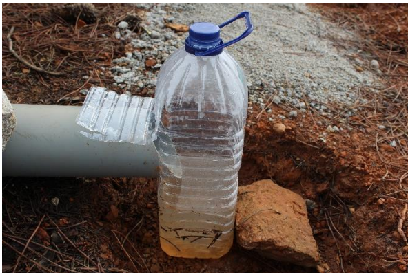
Recolha da água infiltrada
