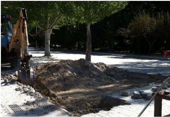
Trabalhos de escavação
