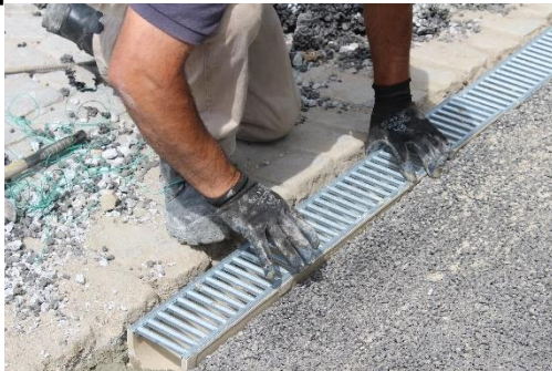
Aplicação da caleira para recolha do escoamento superficial
