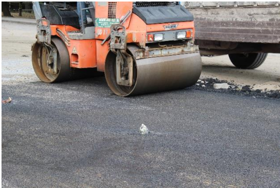
Compactação das camadas betuminosas porosas
