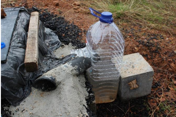
Recolha do escoamento superficial
