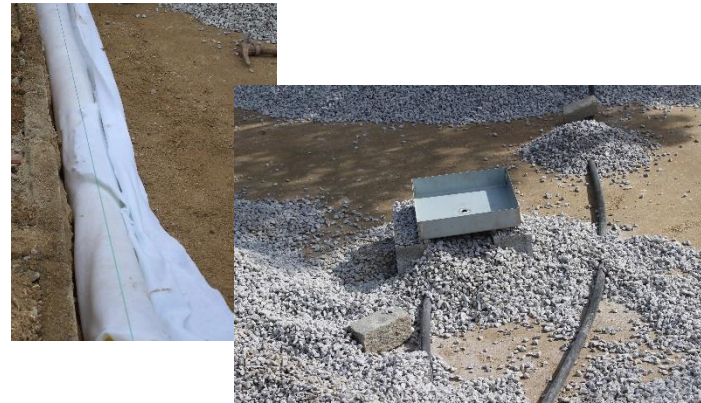
Colocação do dreno
