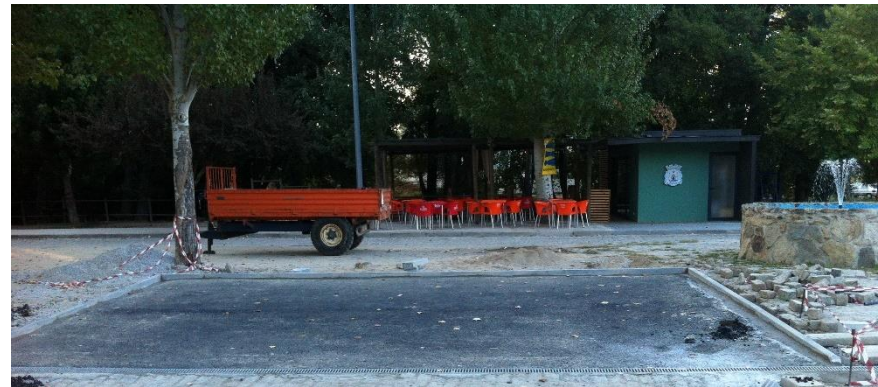
Vista geral do pavimento
