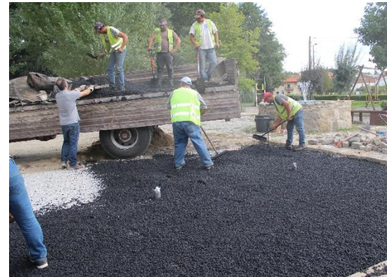
Aplicação das camadas betuminosas porosas
