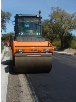
Compactação com cilindro de rasto liso e cilindro de pneus
