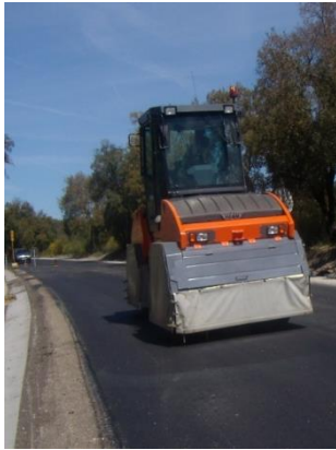
Compactação com cilindro de rasto liso e cilindro de pneus
