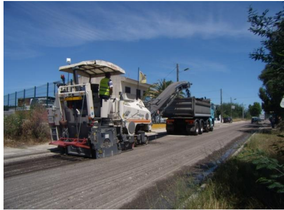
Fresagem do pavimento e transporte para a central
