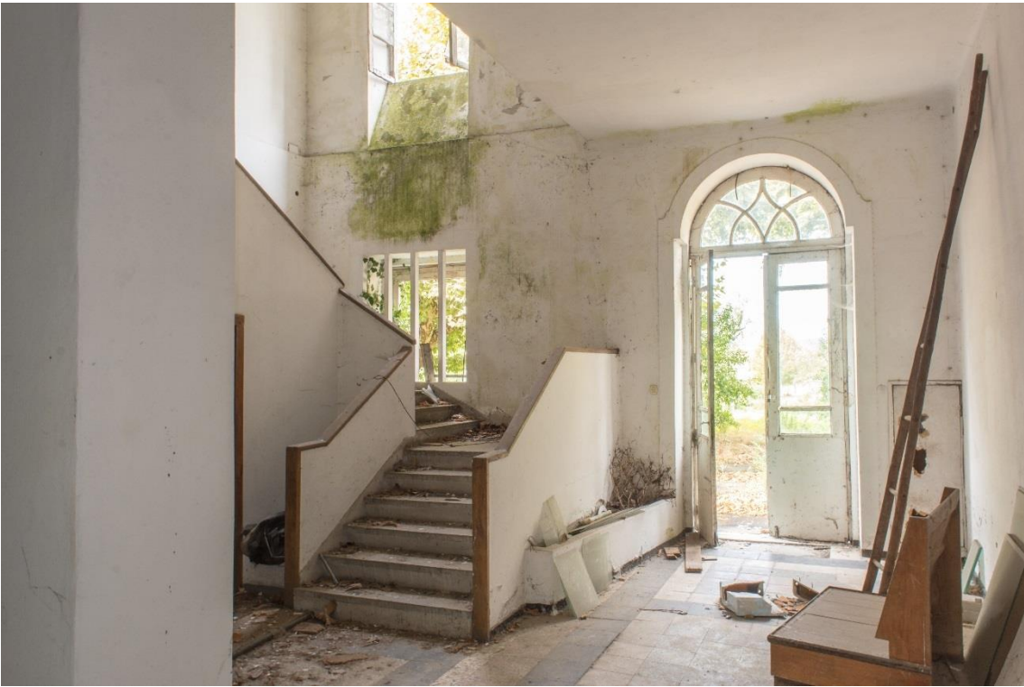
Figura 20. Escada de acesso na entrada do Hotel.
