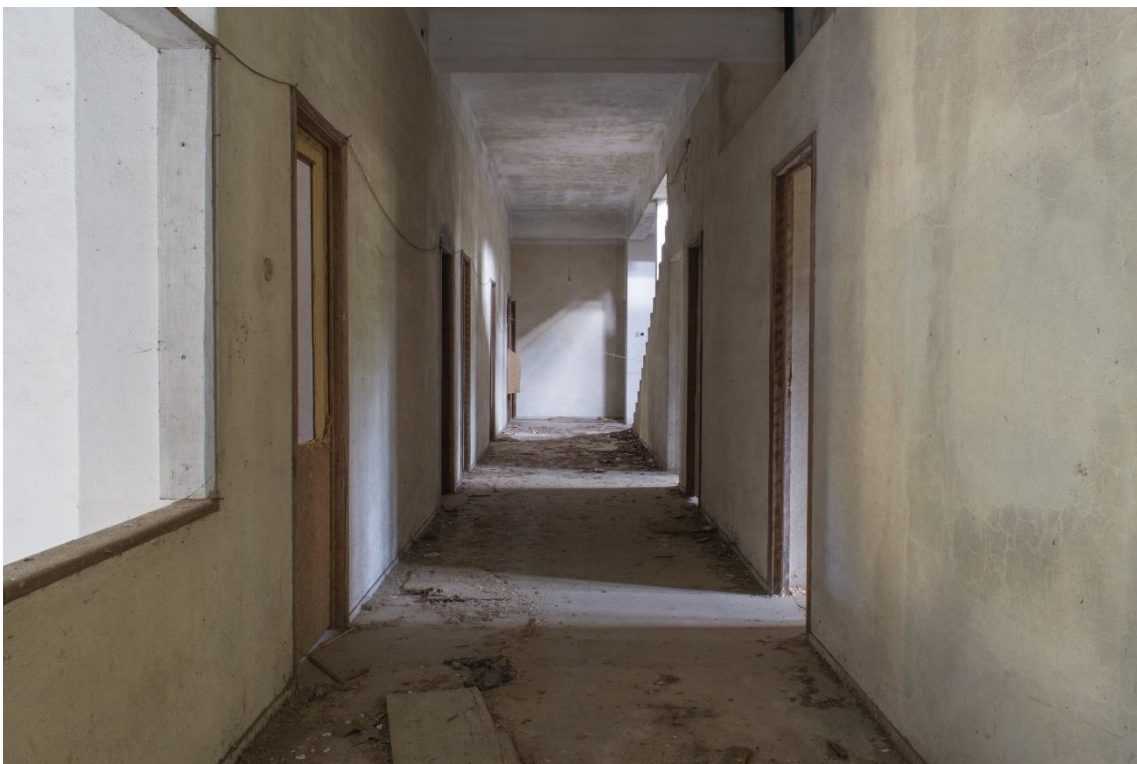
Figura 28. Corredor de acesso aos quartos no 1º piso.
