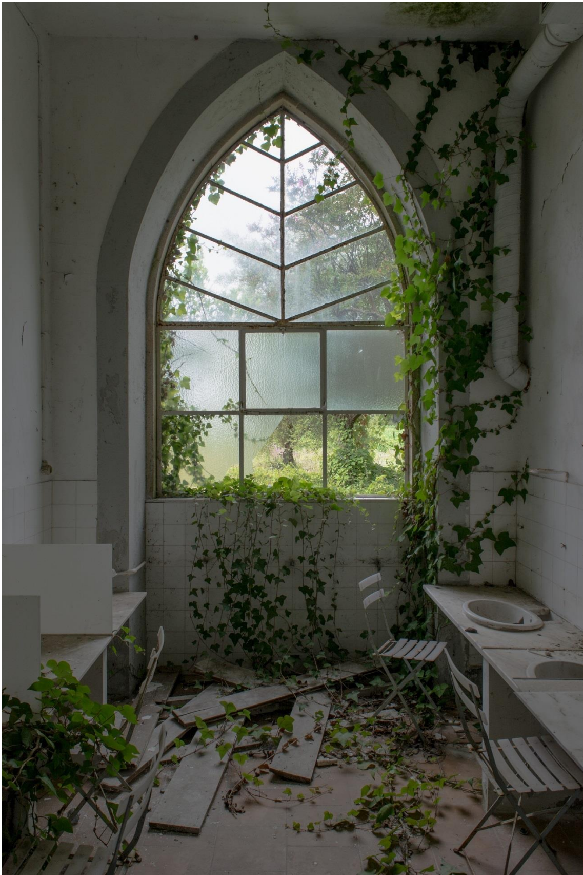
Figura 35. Vão ao fundo do corredor do Balneário.
