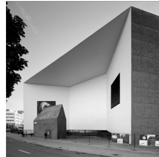
022 Fundación Schaulager, Herzog&Meuron
