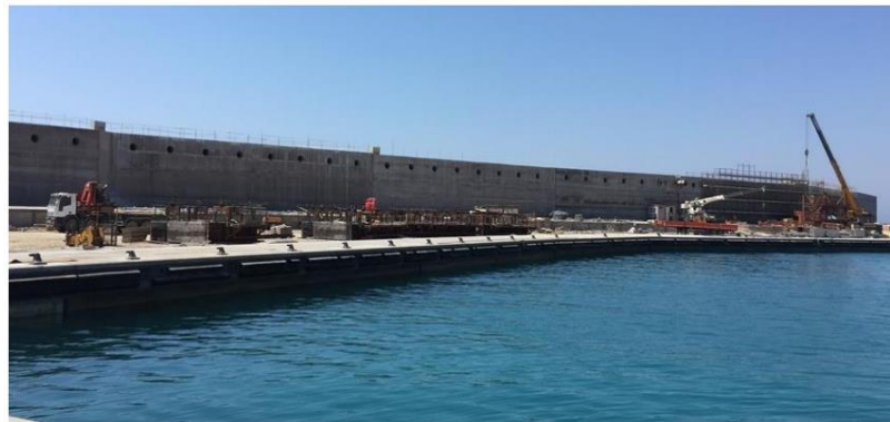
Figura 3.14 - Protótipo U-OWC em construção na central de energia das ondas do porto de Civitavecchia, Roma, Itália. Fonte: Ref. 35 (Spanos P. D. et al. , 2017).
