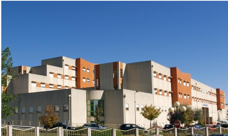
Figura 1- Hospital Pêro da Covilhã
