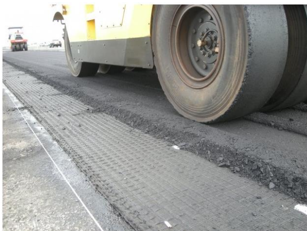
Figura 2.31- Aplicação de Geogrelha (Eco engenharia. Disponível em: http://ecoengenharia.com.br/produtos/geogrelhas-e-tecidos/geogrelha-hatelit/ )
