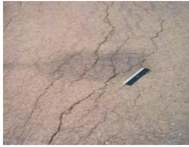
Figura 2.6- Fenda por fadiga (Santos, B., 2002)
