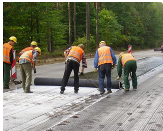
Figura 2.30- Aplicação de Geotêxteis (Tensor. Disponível em: http://www.tensor.pt/Aplicações/Estradas-Áreas-Pavimentadas/Asphalt-Reinforcement )
