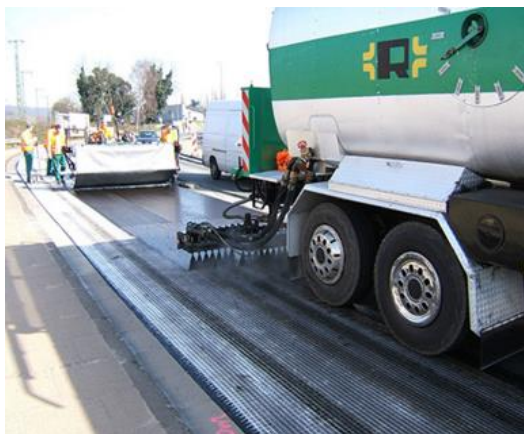
Figura 2.29- Rega para aplicação de geotêxtil (Tensor. Disponível em: http://www.tensor.pt/Aplicações/Estradas-Áreas-Pavimentadas/Asphalt-Reinforcement )
