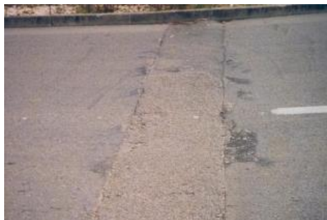
Figura 2.14- Juntas mal elaboradas (Santos, B., 2002)
