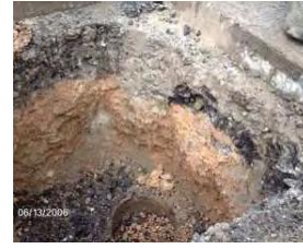
Figura 3.3- Abertura de poços (Alves, T., 2007 citado por Santos, M., 2009)
