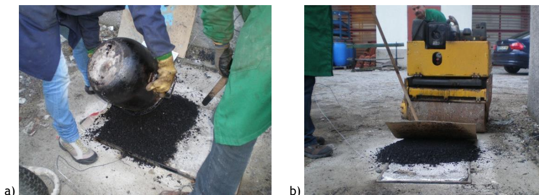
Figura 4.23 - Compactação das lajetas com o cilindro de rolos (DECA-UBI)
