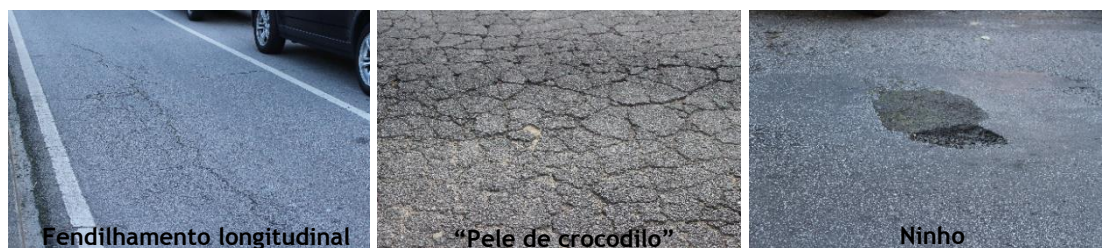
Figura 3.2 - Evolução do fendilhamento por fadiga (Covilhã)
