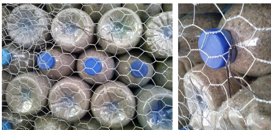
Figura 4.14. Pormenor de fixação da tela hexagonal.
