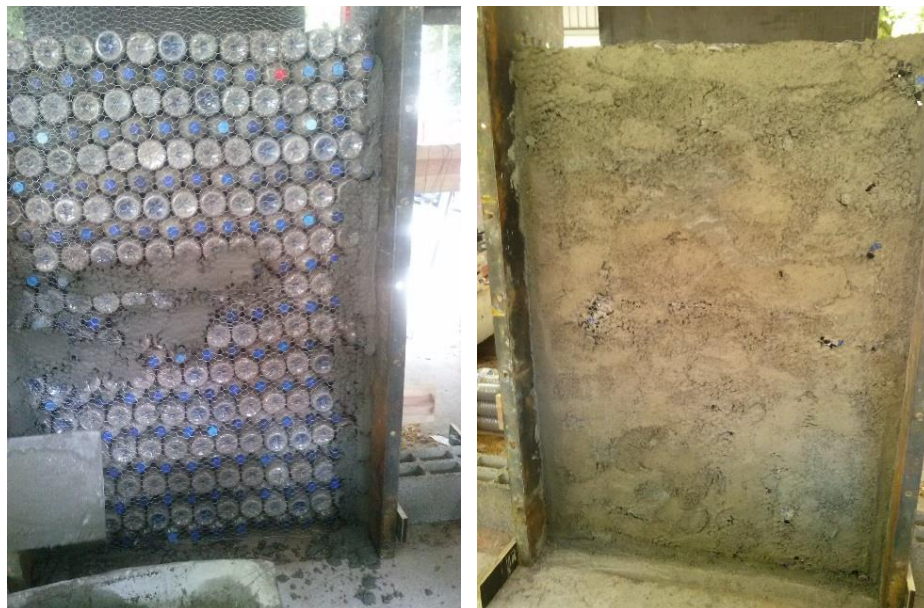
Figura 4.15. Iniciação de reboco, 1º Fase
