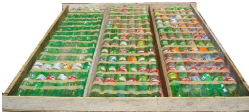
Figura 2.10. Colocação das colunas de garrafa plásticas e treliça de reforço (Fonte: Provenzano, 2006)
