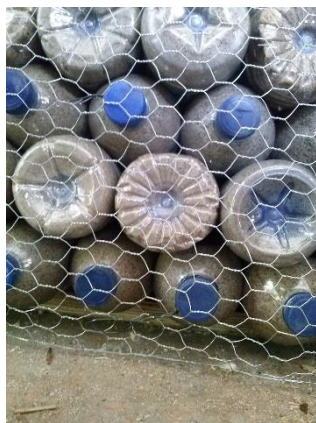
Figura 4.13. Pormenor da zona em contato com o chão sem a necessidade de suporte
