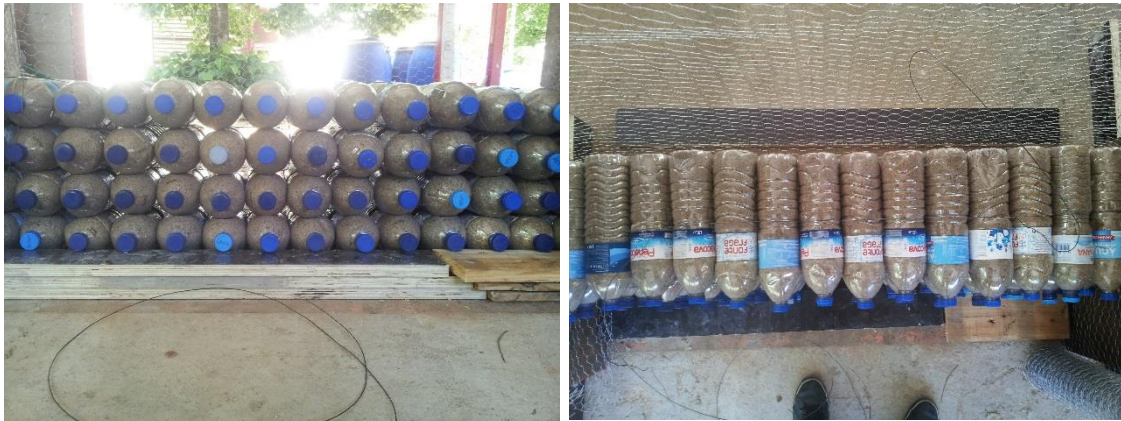
Figura 4.8. Percepção da utilização de armadura entre o PET
