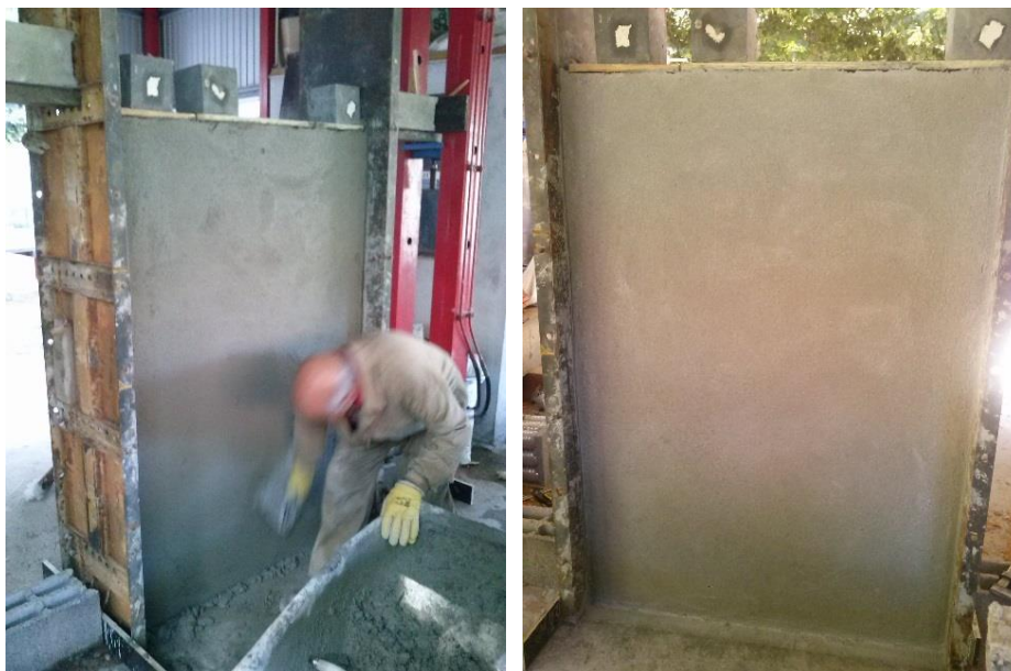
Figura 4.16. Acabamento do reboco, 2º Fase
