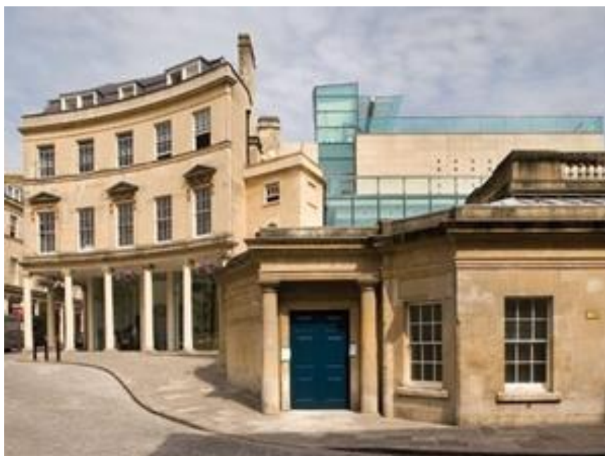
Edifício Hot Bath 24
