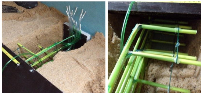
Figura A5. 12: Instalação do sistema de piezômetros.
