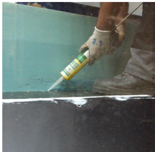
Figura A5. 5: Preenchimento das juntas com um produto que cola e veda (parte 1).
