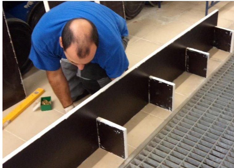
Figura A5. 1: Montagem do topo do leito fixo.
