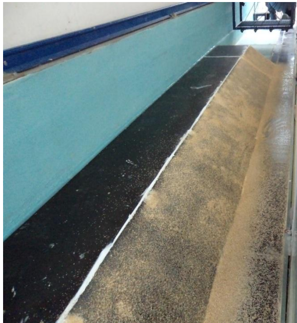
Figura A5. 7: Colocação da superfície rugosa no talude fixo (parte 1).
