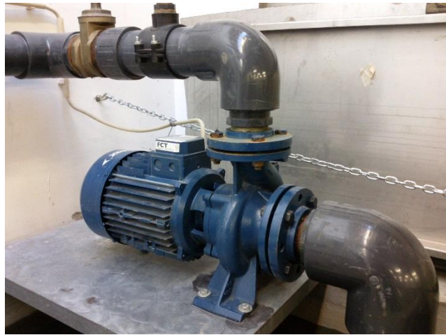
Figura A4. 6: Torneiras de controlo de caudal e bomba centrífuga do canal ( Q_{\text{máx}} 140 m 3 /h).
