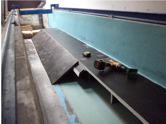
Figura A5. 3: Colocação e montagem do talude fixo (parte 2).
