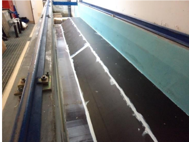
Figura A5. 6: Preenchimento das juntas com um produto que cola e veda (parte 2).
