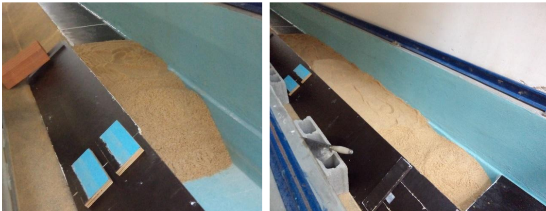
Figura A5. 10: Colocação da areia.
