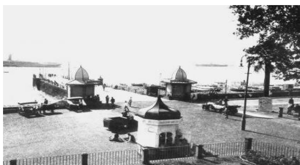
Fig. 68 - Cais do Funchal e Entrada da Cidade, 1935
