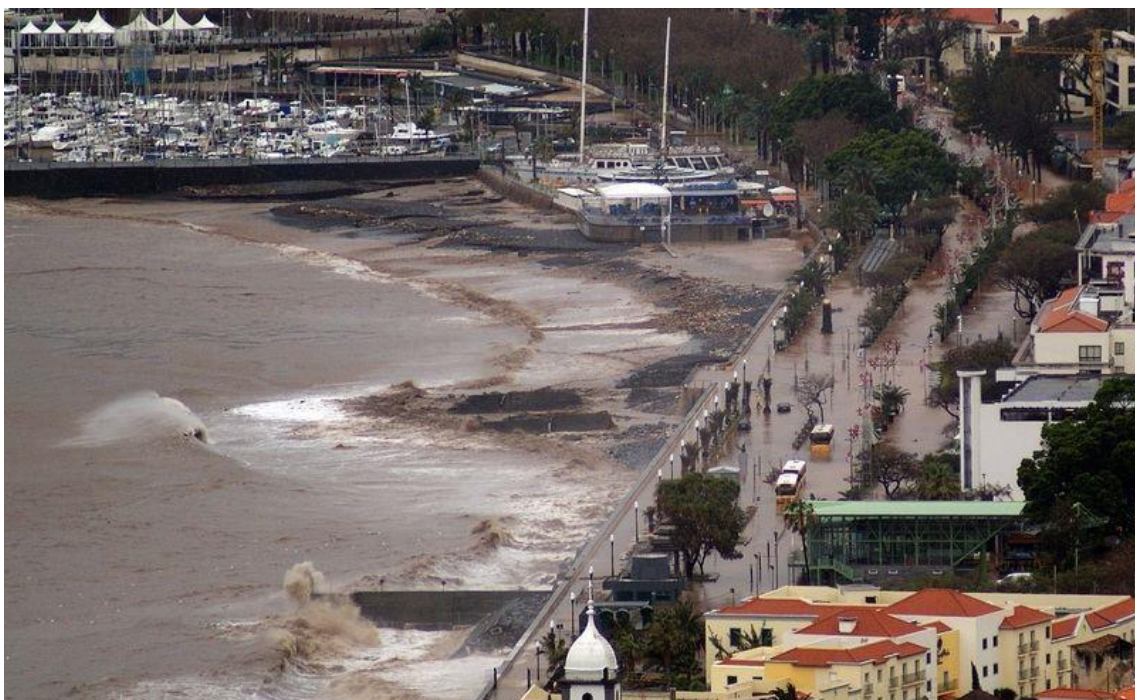
Fig. 78 - Avenida do Mar e das Comunidades Madeirenses, vista aérea, 20 de fevereiro de 2010
