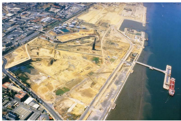
Fig. 37 - Zona Oriental, após o início das obras da Expo’98. (Fonte: Digitalização do Livro, Expo’ 98 Exposição Mundial de Lisboa - Arquitetura, p.12)
