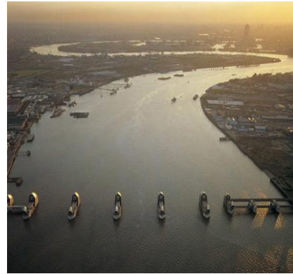
Fig. 30 - Eclusas sobre o rio Tamisa, Londres. (Fonte: http://www.london-attractions.info/thames-barrier-information-centre.htm ,Acedido: 30 de Julho, 2013)
