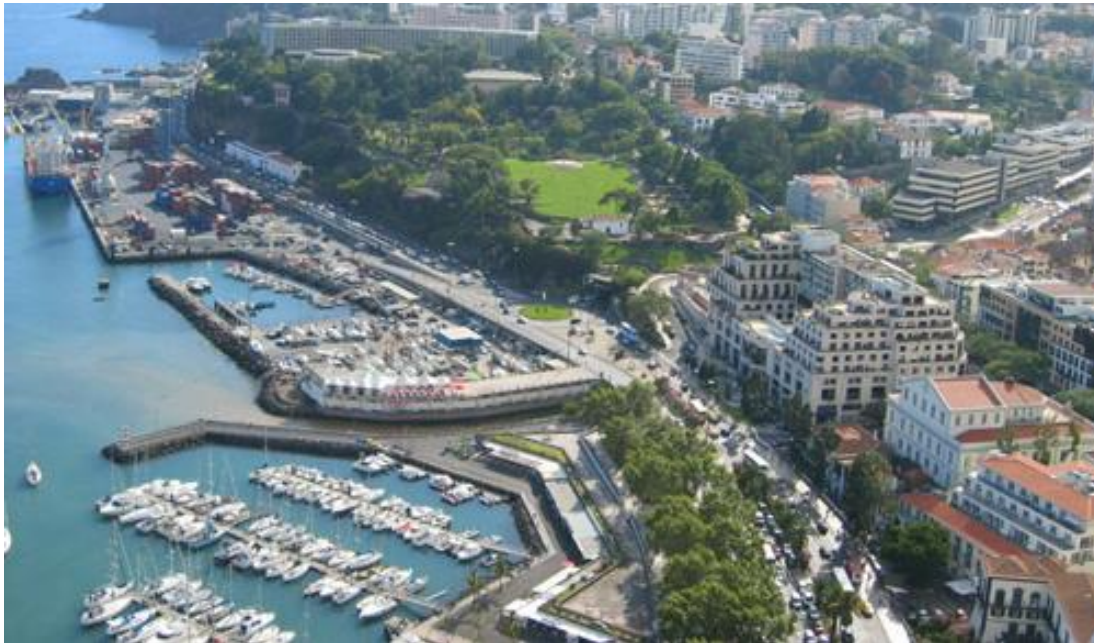
Fig. 77 - Avenida do Mar e das Comunidades Madeirenses e Marina do Funchal antes do 20 de fevereiro de 2010.
