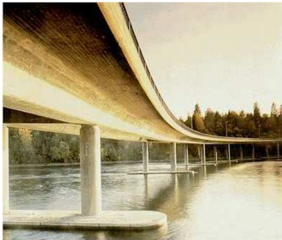
Figura 2.6. Ponte New Eidsvoll Bridge, na Noruega [109]
