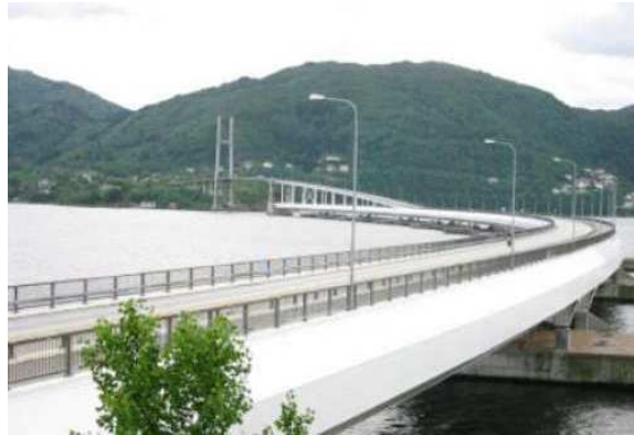
Figura 2.7. Ponte Nordhordland, na Noruega [109]
