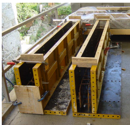
Figura 4.11. Cofragem metálica com as armações das vigas
