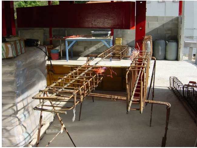
Figura 4.4. Armações das vigas de ensaio
