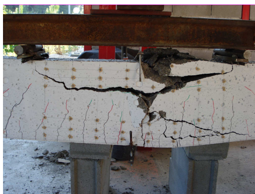
Figura 4.24. Rotura da viga S2-46,98-1,55
