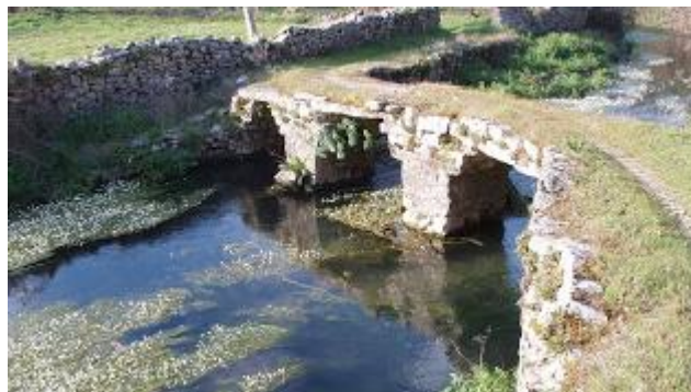
Figura 1.15: Ponte pedonal em pedra em Moinho João da Serra, Ansião [j]
