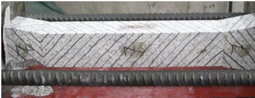
Figura 5.27: Destacamento de uma aresta do capitel do provete 7 (macaco hidráulico à esquerda)
