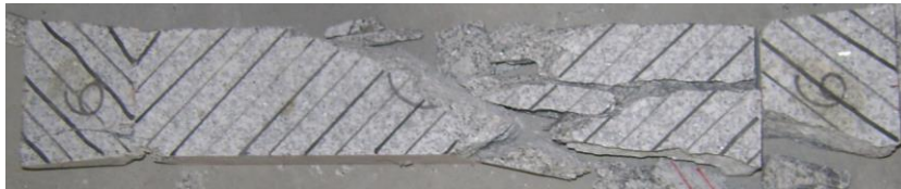
Figura 5.25: Reconstituição do provete 6, face E3 (macaco hidráulico à esquerda)
