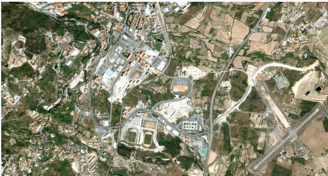
Figura 8.18 – Vista geral da área de teste (extraído de Google Earth ).
