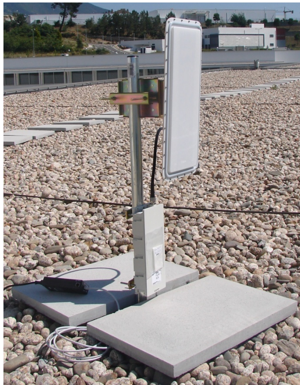
Figura 9.1 – Estação Base AUS-SA com antena sectorial de 120°.
