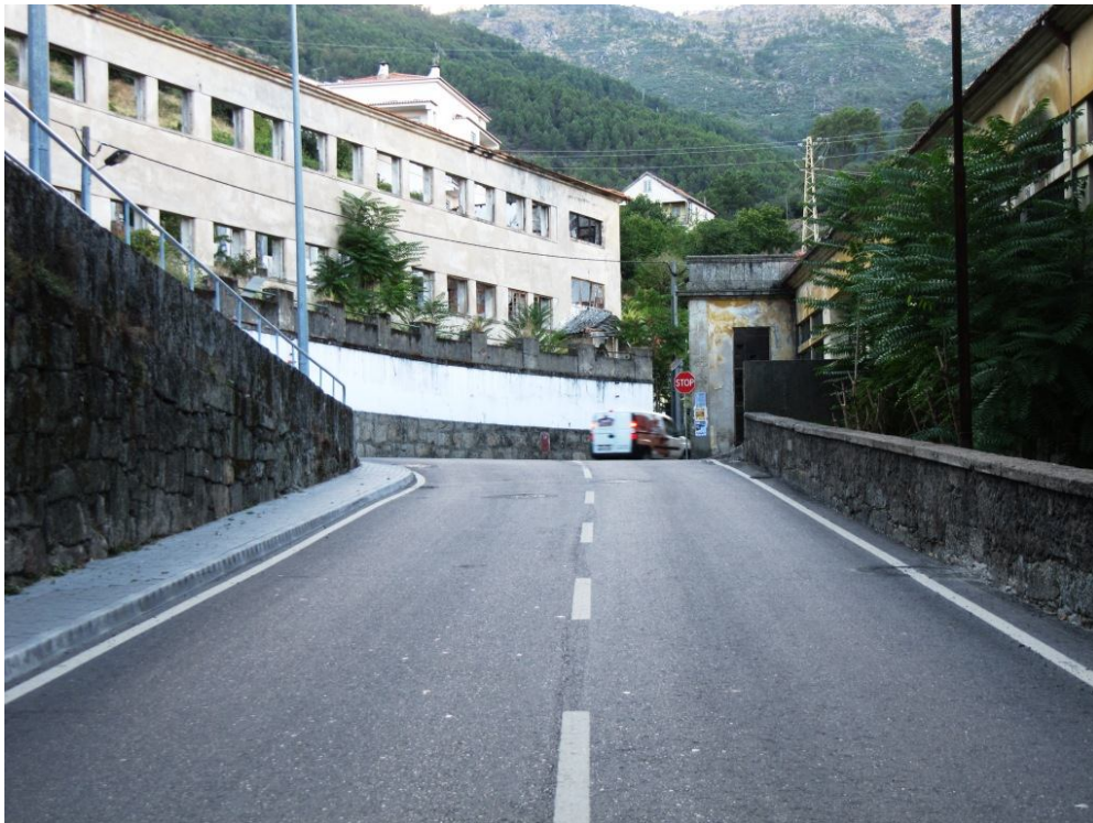
Figura 54 – Vista sobre a zona em estudo (no sentido ascendente da Estrada da Fábrica Velha)
