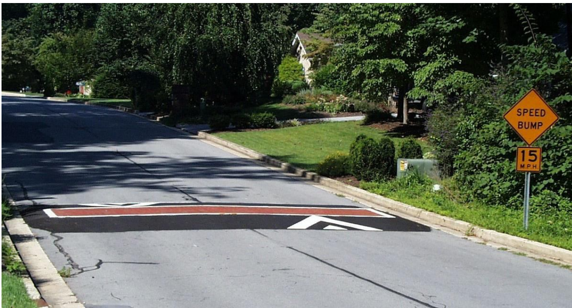
Figura 17 - Exemplo da Aplicação de uma lomba [USA, 2009]
