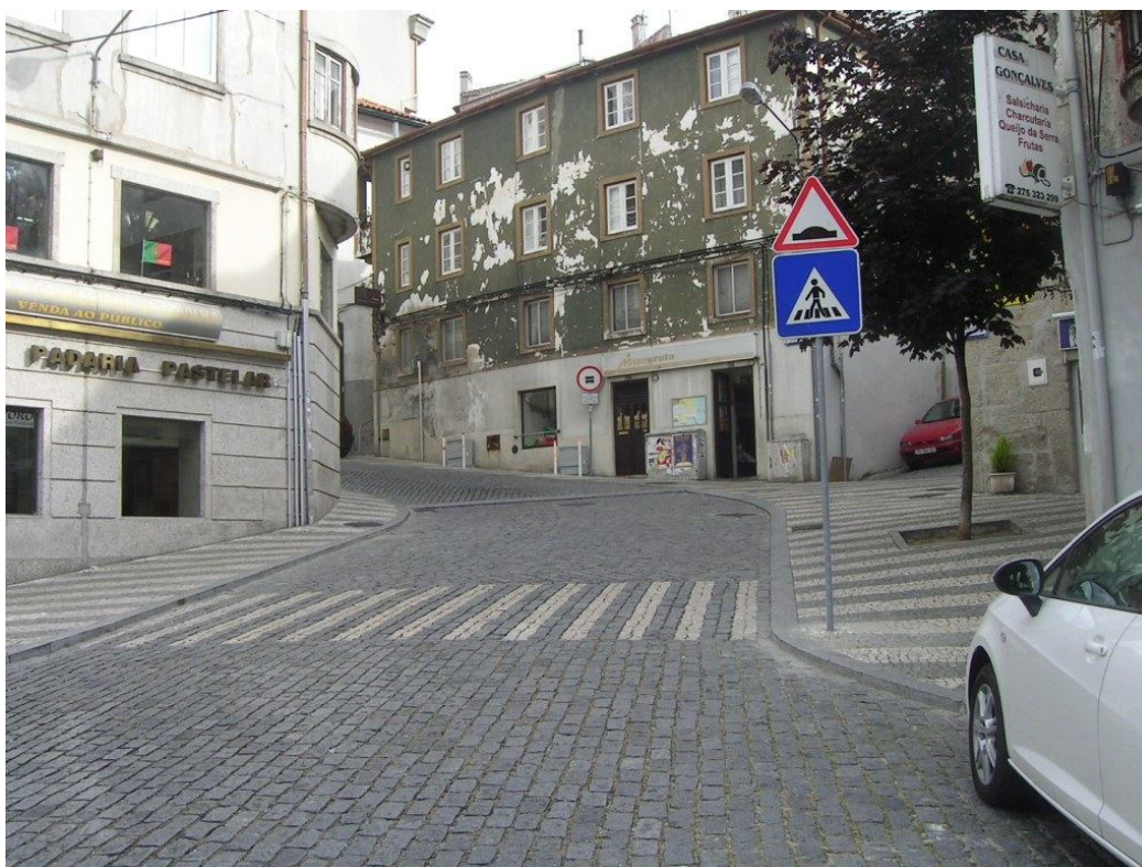
Figura 38 – Elevação da via no início da rua e respectiva sinalização (Norte)
