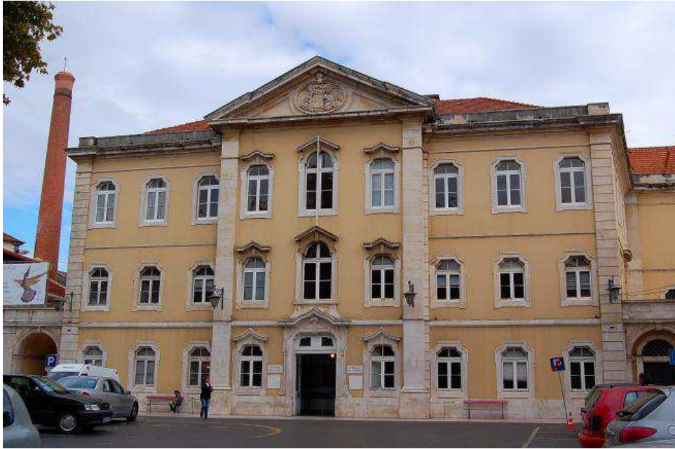
Figura 2. 5 - Hospital Termal das Caldas da Rainha (Fernandes, 2011).
