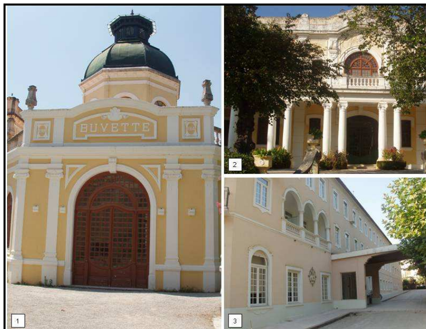
Figura 3. 6 - Conjunto edifícios que constituem o complexo termal da Curia: buvette (1), balneário (2), hotel das termas (3).
