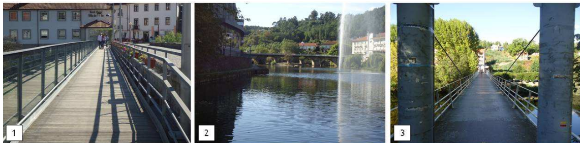
Figura 3. 24 - Passadiço pedonal em madeira (1), ponte rodoviária (2), e ponte metálica pedonal (3) na ligação das duas vias principais, em ambas as margens do rio Vouga, na estância termal de S. P. do Sul.
