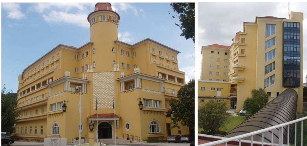
Figura 3. 14 - Grande Hotel do Luso e túnel de acesso ao edifício das termas.
