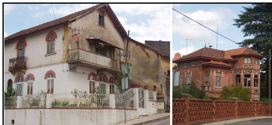
Figura 3. 18 - Edifícios com características arquitetónicas singulares, nas proximidades das Termas do Luso.
