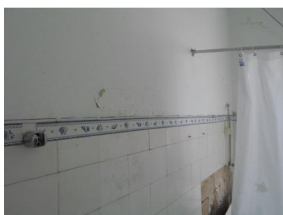
Figura 19 - Revestimento com azulejo cerâmico a meia parede (instalação sanitária).
