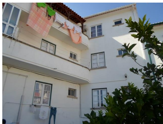
Figura 9 - Fachada posterior do edifício orientada para Sul (S).
