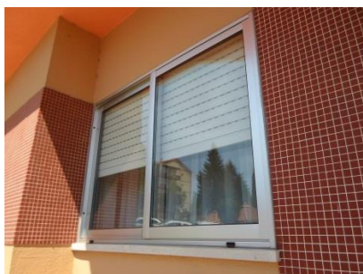
Figura 48 - Envidraçado com caixilharia metálica de alumínio com corte térmico (segunda janela).
