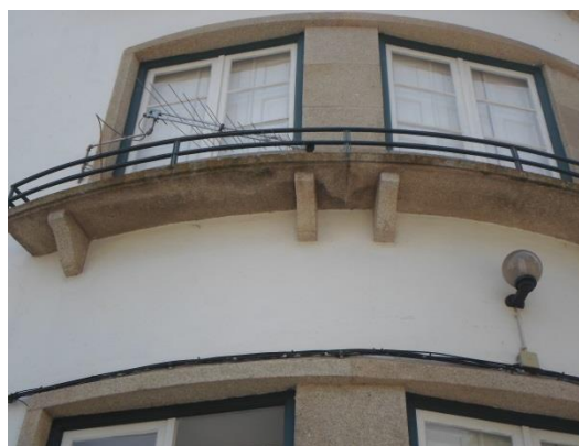
Figura 12 - Peitoris e ombreiras dos vãos envidraçados da fachada principal do edifício.
