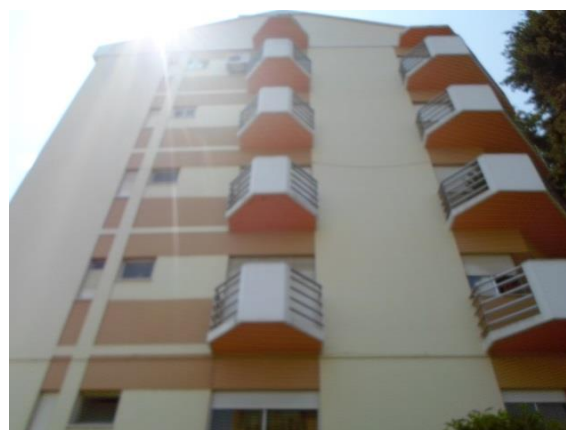
Figura 47 - Fachada lateral do edifício com orientação para Este (E).
