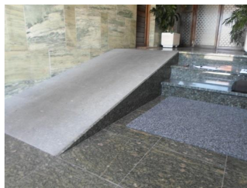
Figura 55 - Rampa e lance de três degraus.
