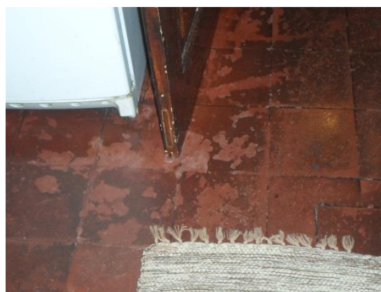
Figura 22 - Revestimento cerâmico (mosaico).
