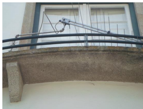
Figura 14 - Vão envidraçado com caixilharia de madeira, com quadrícula.
