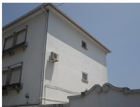
Figura 7 - Fachada lateral do edifício orientada para Sudoeste (SW).
