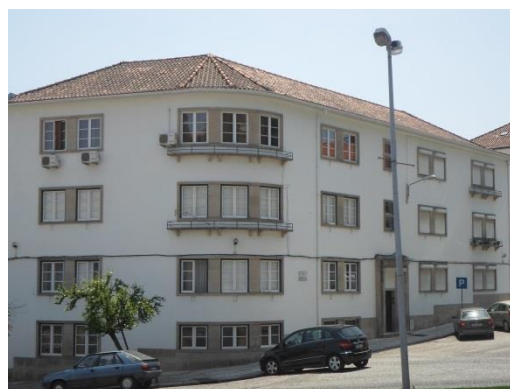
Figura 5 - Edifício Multifamiliar, cuja época de construção remete para a década de 50.
