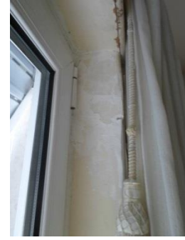
Figura 33 - Caixilharia de PVC com vidro duplo e caixa-de-ar.
