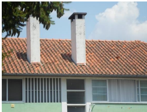
Figura 34 - Cobertura do edifício.
