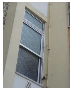
Figura 50 - Envidraçado com caixilharia de alumínio (marquise).
