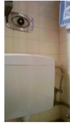
Figura 63 - Parede de compartimentação de um WC interior revestida com azulejo cerâmico.
