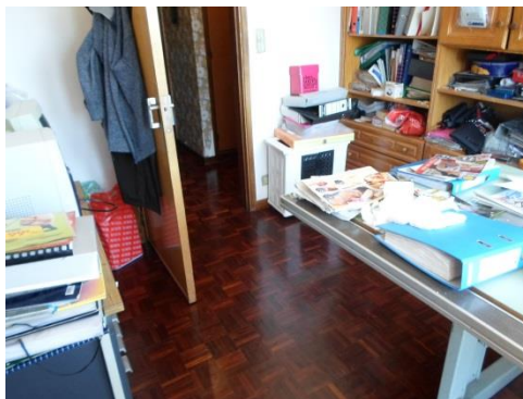
Figura 64 - Revestimento do pavimento em soalho de madeira.
