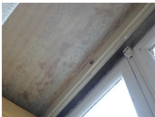
Figura 15 - Pormenor das paredes que confinam a envolvente exterior opaca.
