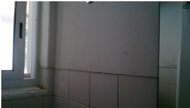
Figura 40 - Paredes revestidas com azulejo cerâmico até meia parede e estuque tradicional como acabamento, em zonas húmidas.
