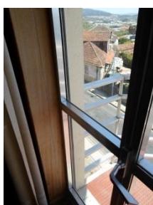
Figura 52 - Caixilharia metálica de alumínio (fixa e de batente).
