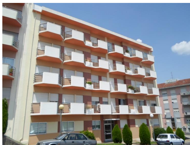
Figura 44 - Edifício multifamiliar da década de 70.
