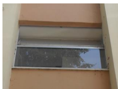
Figura 53 - Caixilharia metálica de alumínio (oscilante) em zonas de escadas.
