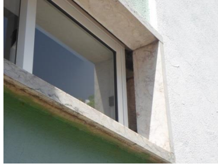
Figura 32 - Caixilharia de Aluminio, com vidro simples.
