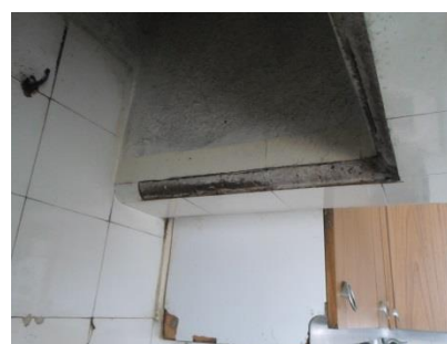
Figura 20 - Revestimento a meia parede com azulejo cerâmico (cozinha).
