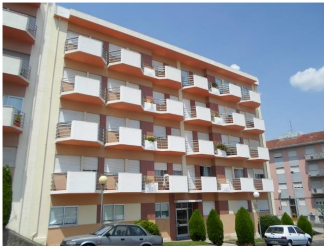
Figura 45 - Fachada principal do edifício com orientação para Sul (S).
