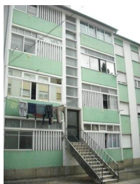
Figura 29 - Fachada posterior do edifício com orientação para Sudoeste (SW).
