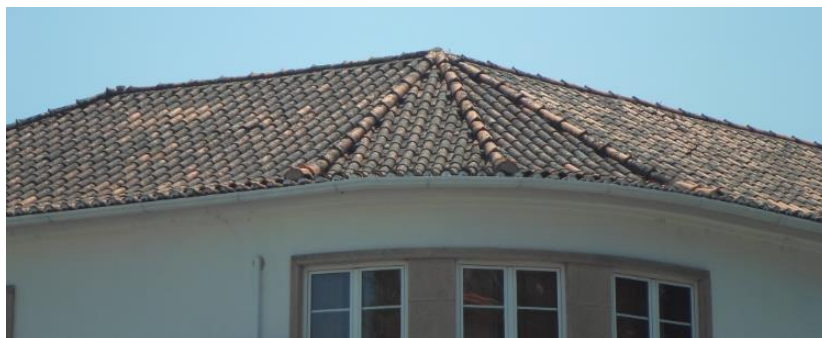
Figura 26 - Cobertura do edifício.
