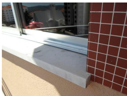
Figura 49 - Envidraçados originais com caixilharia metálica de alumínio, sem corte térmico.
