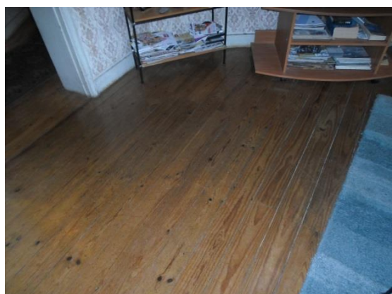
Figura 21 - Pavimento em soalho de madeira.
