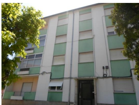
Figura 28 - Fachada principal do edifício com orientação para Nordeste (NE).
