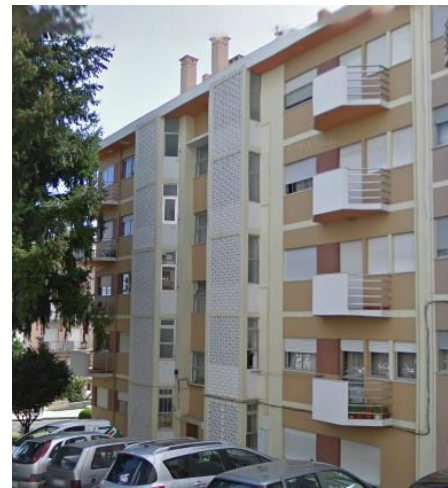
Figura 46 - Fachada posterior do edifício com orientação para Norte (N).
