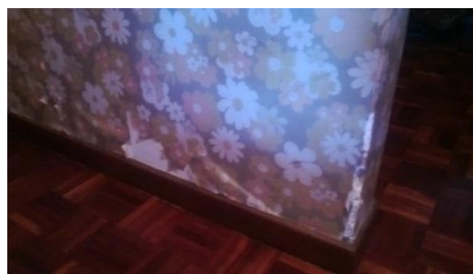
Figura 61 - Aplicação de papel de parede em paredes de compartimentação interior.
