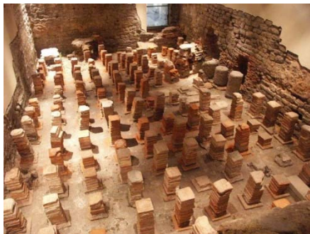
Figura 3.3 - Caldarium em Bath (int. 3).
