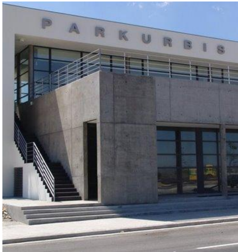
Fig. 238 - Pormenores da entrada lateral (2012)
