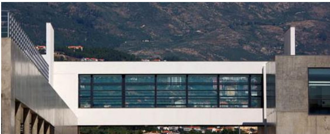
Fig. 220 e 221 - Vista geral e pormenor do passadiço do edifício Parkurbis (2005)
