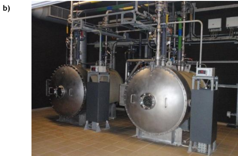
Figura 8- Pré-oxidação a) Esquema de funcionamento da pré-oxidação; b) Fotografia dos reatores.
