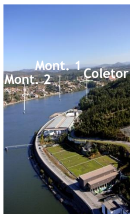
Figura 28- Localização dos Poços de Captação e Poço Coletor na Albufeira de Crestuma-Lever.
