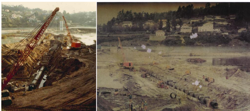
Figura 3 - Fotos da construção dos poços de captação (1985).
