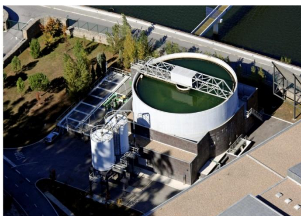
Figura 14- Unidade de Tratamento de Lamas
