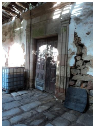
Figura 85. Vista do material usado para construção e revestimento da parede.
