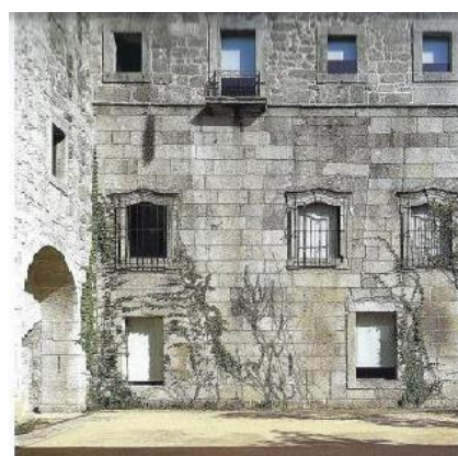
Figura 98. Reabilitação do Mosteiro de S. Mª. do Bouro.
