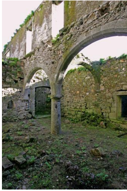
Figura 132. Antes da Reabilitação.
