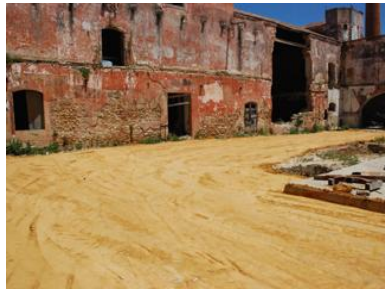
Figura 108. Aspeto do Mosteiro de Tavira, antes da reabilitação, espaço exterior.
