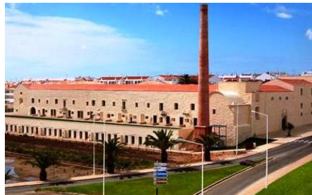
Figura 116. Mosteiro de Nossa Senhora da Conceição de Tavira. Vista do conjunto reabilitado.
