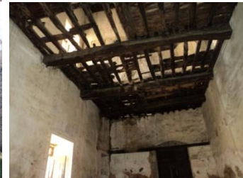
Figura 80. Teto do piso inferior em madeira.
