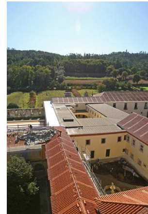
Figura 137. Vista da nova cobertura. Mosteiro Tibães.
