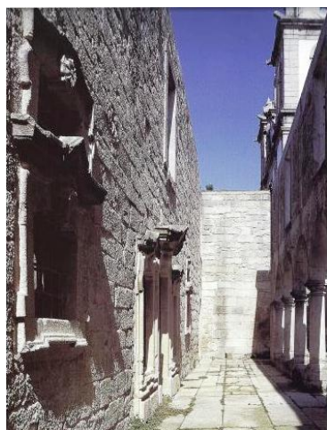
Figura 96. Reabilitação do Mosteiro de S. Mª. do Bouro.
