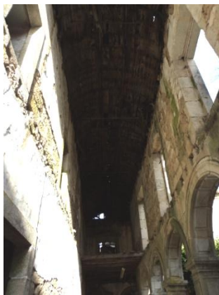
Figura 82. Vista da abobada de berço do piso superior.
