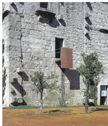
Figura 97. Reabilitação do Mosteiro de S. Mª. do Bouro. Pormenor do material usado na varanda.
