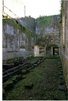
Figura 134. Antes da Reabilitação. Refeitório
