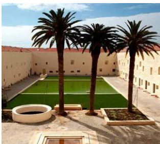
Figura 115. Mosteiro de Nossa Senhora da Conceição de Tavira. Vista para o pátio depois da reabilitação.
