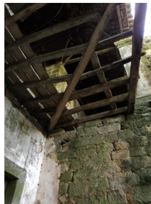
Figura 83. Pormenor do emparelhamento da pedra.
