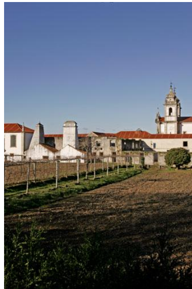
Figura 118. Mosteiro de Tibães. Antes da intervenção.
