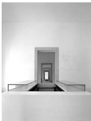
Figura 93. Mosteiro de Alcobaça, Ala de São Bernardo, aspetos de reabilitação.
