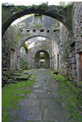
Figura 128. Antes da Reabilitação. Circulação.
