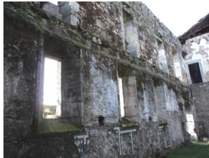
Figura 79. Lambril de azulejo no revestimento das paredes do refeitório.
