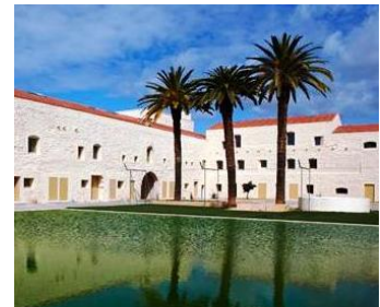
Figura 117. Mosteiro de Nossa Senhora da Conceição de Tavira. Vista da piscina para o conjunto edificado depois de reabilitado.
