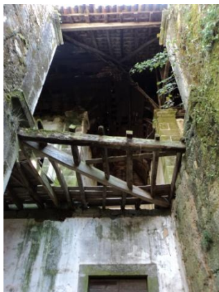
Figura 81. Veja-se o assentamento do soalho do piso superior.
