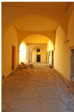
Figura 129. Depois da Reabilitação. Circulação.
