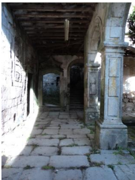
Figura 78. Pavimento coberto por um lajeado de granito.
