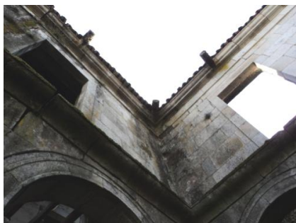
Figura 59. Gárgulas que canalizam a água da chuva.
