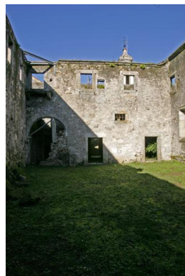
Figura 130. Antes da Reabilitação. Pátio.
