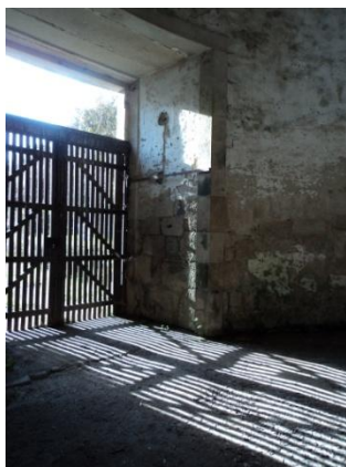
Figura 84. Pormenor do reboco pintado sobre a pedra.
