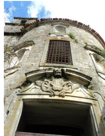
Figura 71. Fachada principal da Igreja e porta de entrada
