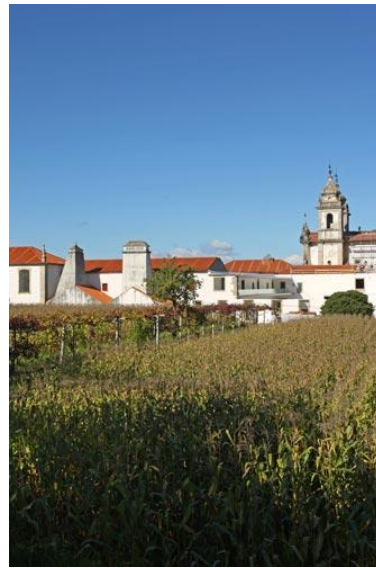
Figura 119. Mosteiro de Tibães. Depois da intervenção.
