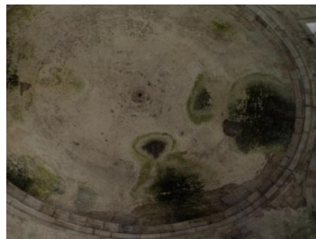
Figura 74. Abóboda em tijolo
