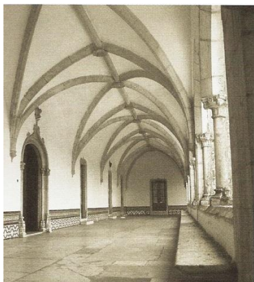
Figura 36. Mosteiro de São Dinis de Odivelas
