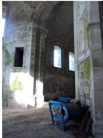
Figura 70. Vista para a capela-mor
