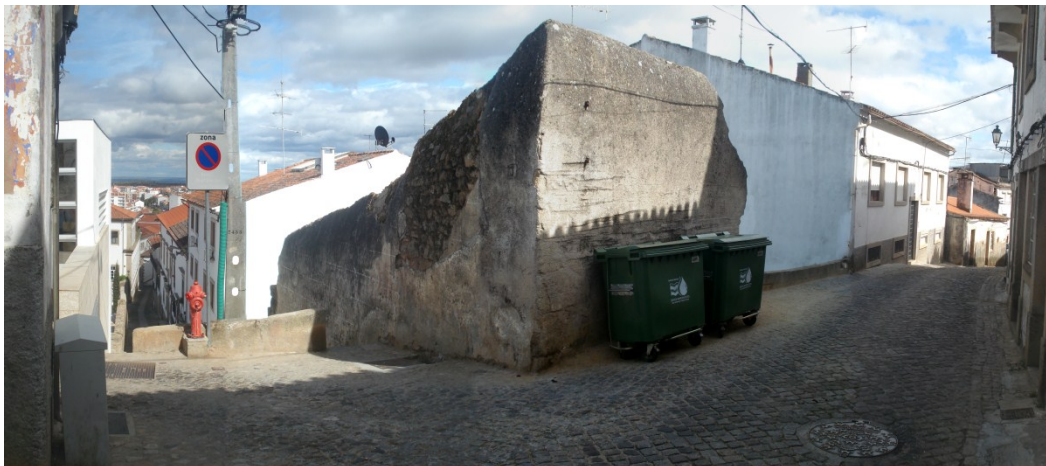
FIG.46 Lote de intervenção, vista de cota Superior, Rua do Arresário.
