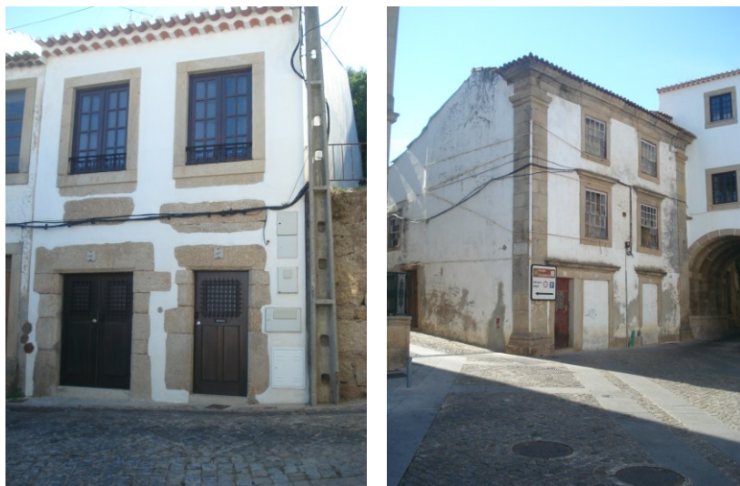
FIG.58 Imóvel nº38 (à esquerda) em ótimo estado de conservação.
