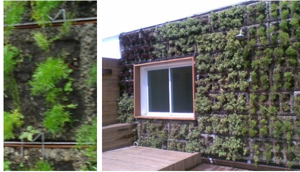
FIG.21 Fases de montagem do sistema de rega em parede viva modular.
