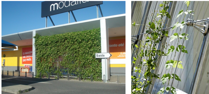
FIG.5 Fachada verde em superfície comercial, Fundão; Portugal.
