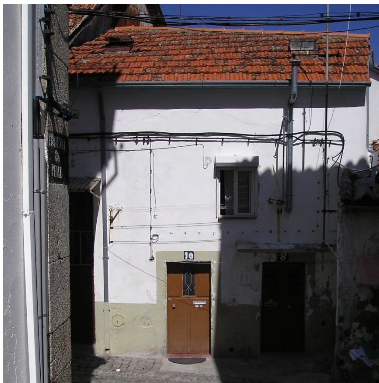
Figura 9: Habitação reduzida na Rua 6 de Setembro - Fonte: Foto tirada pelo autor
