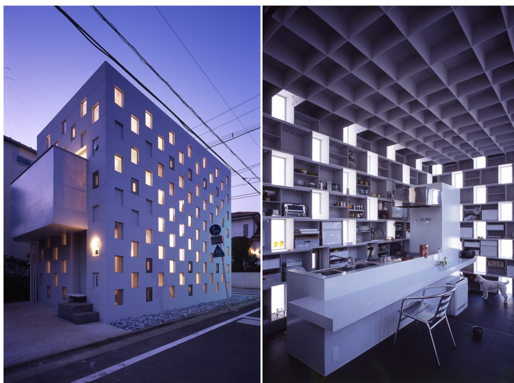
Figura 19: Cell Brick House , exterior - Fonte:
