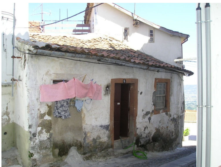
Figura 10: Habitação reduzida na Rua 6 de Setembro - Fonte: Foto tirada pelo autor
