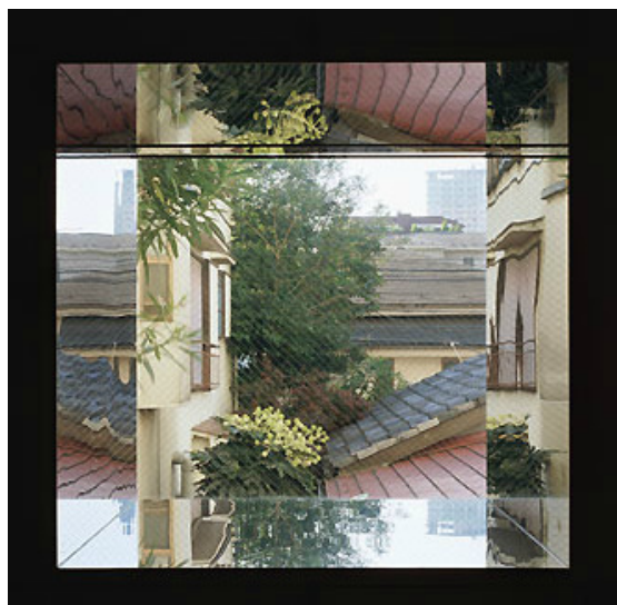
Figura 28: Pormenor da janela de Studio Gotenyama - Fonte: http://www.chibamanabu.jp/
