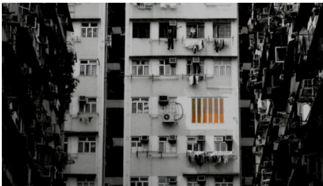
Figura 16: Fachada do prédio de Gary Chang - Fonte: http://blog.kineticarchitecture.net/2011/03/32m2/
