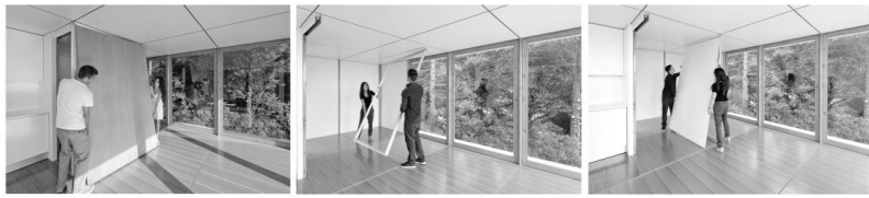
52. Painéis-parede que permitem a flexibilidade interior
