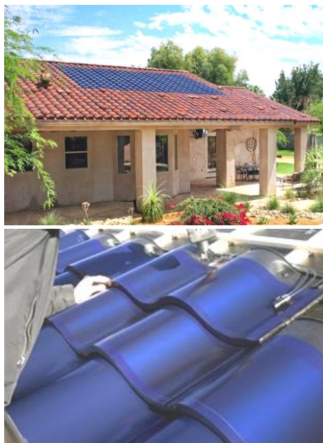
Figura 41 – Exemplo de uma aplicação de telhas com células fotovoltaicas. (tecnologia.terra.com.br/noticias/0,,OI4009195-EI12882,00-Telhas+mais+discretas+sao+opcao+para+energia+solar.html, consultado em Abril de 2011)
