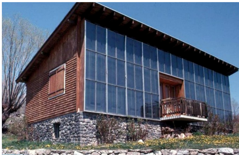
Figura 2.1 - Protótipo de casa solar criada por Félix Trombe e Jacques Michel, em Odeillo, França [9].
