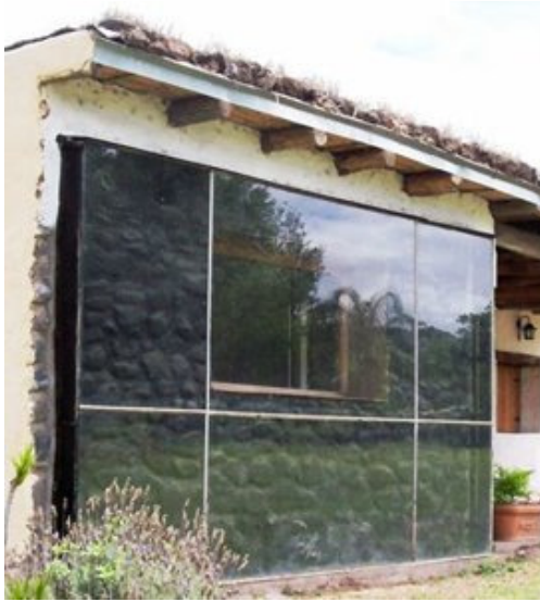
Figura 2.7 - Superfície exterior de uma parede de Trombe pintada de preto [27].
