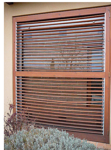
Figura 2.18 - A existência do sombreamento exterior disfarça a parede de Trombe [55].
