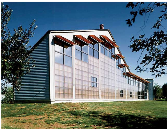
Figura 2.17 - Dispositivo de sombreamento exterior em parede de Trombe [55].
