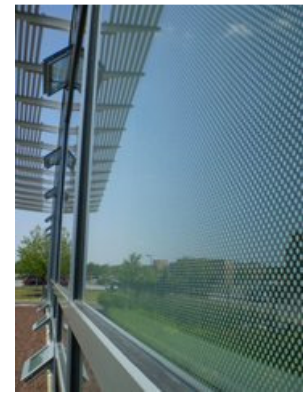
Figura 2.15 - Introdução de película reflectora da radiação solar [40].
