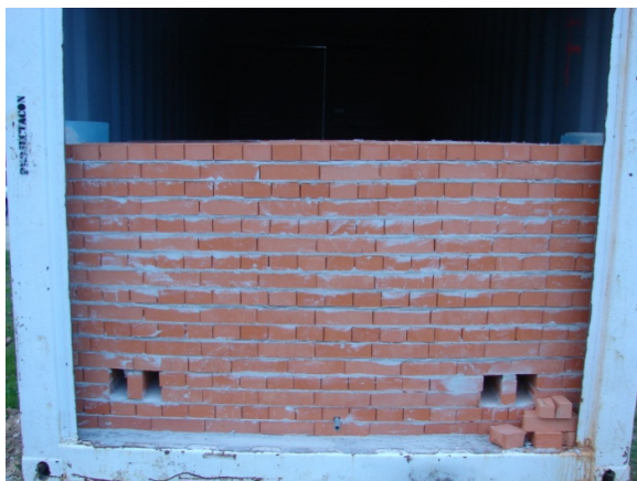
Figura 4.6 - Construção das aberturas de ventilação inferiores.
