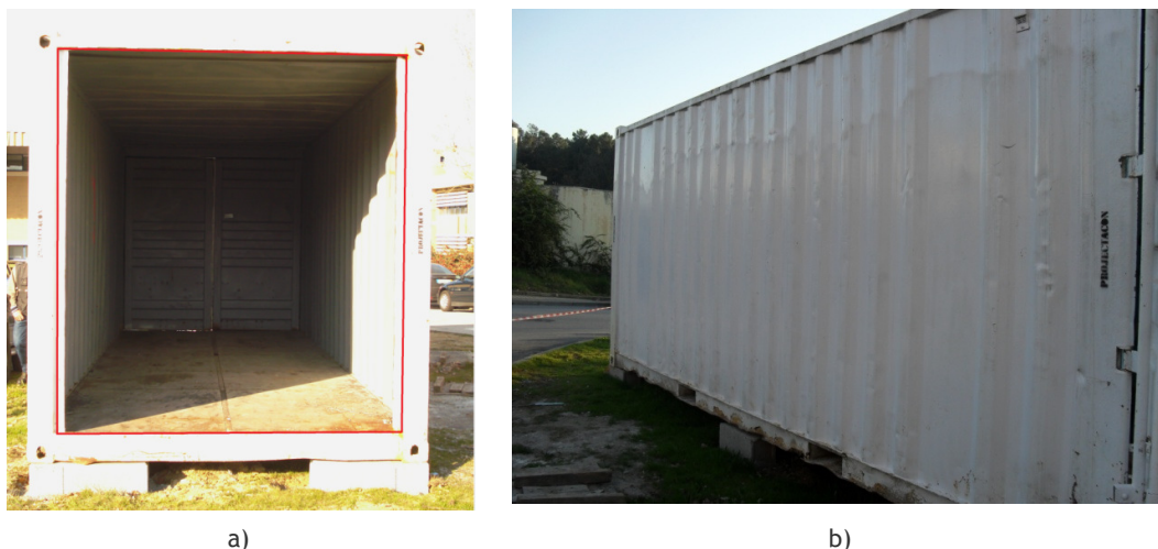
Figura 4.4 - Contentor que serviu de base à construção da célula de teste: a) remoção da fachada orientada a Sul; b) blocos de betão para assentamento.
