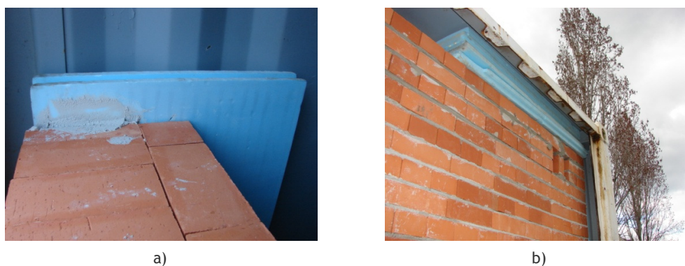
Figura 4.5 - Colocação de isolamento térmico na envolvente: a) paredes exteriores; b) cobertura.
