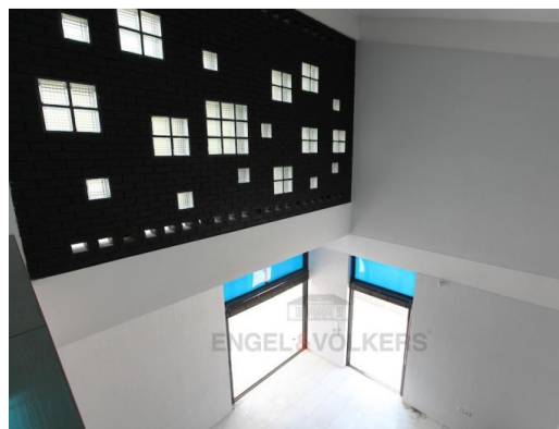
Figura 2.31 - Aplicação de uma parede de Trombe num edifício bioclimático na Grécia [62].
