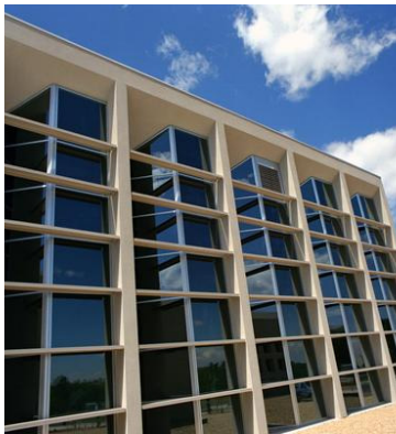
Figura 2.13 - O tipo de envidraçado utilizado disfarça a existência da parede de Trombe [38].
