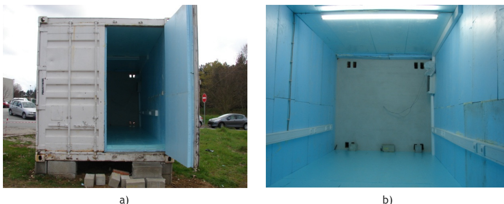
Figura 4.9 - Isolamento térmico da envolvente do contentor; a) visualização da espessura de XPS aplicada nas paredes e no pavimento; b) vista interior do contentor.
