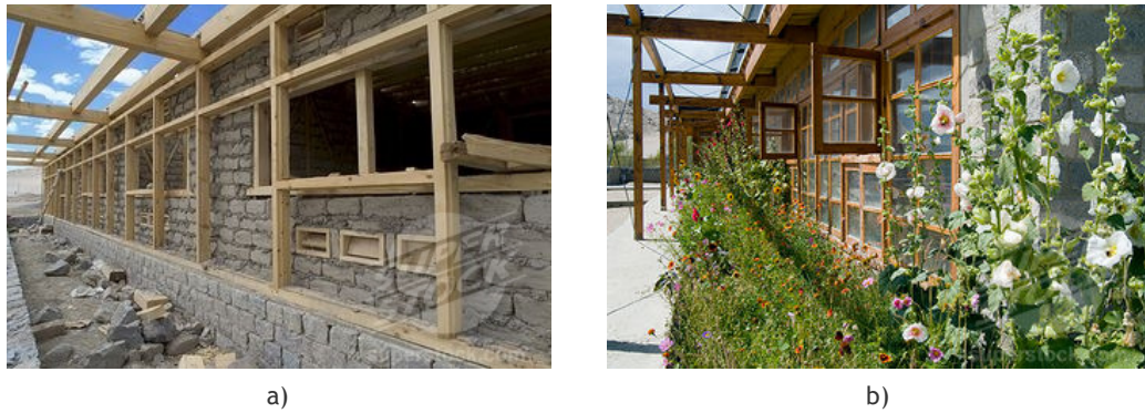
Figura 2.19 - Parede de Trombe ventilada numa escola na Índia ( Best Green Building 2002 ): a) fase de construção; b) fase de conclusão [56].
