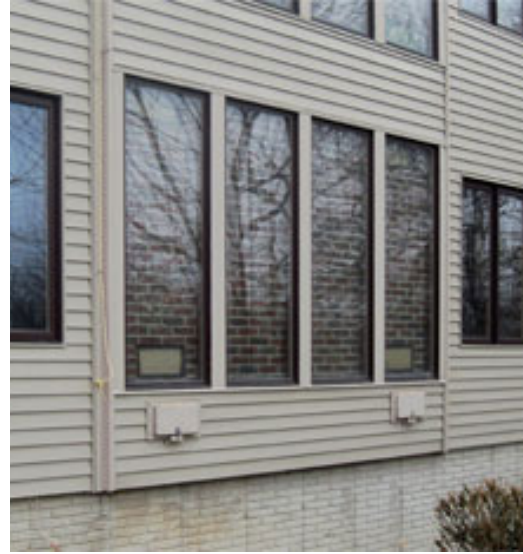
Figura 2.8 - Parede de Trombe em tijolo sem pintura [28].
