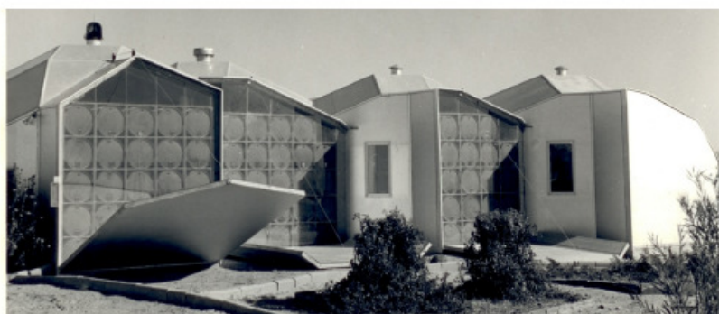
Figura 3.3 - Dispositivo de sombreamento amovível ( Baer Zome Cluster, Corrales, NM 1972 ) [92].
