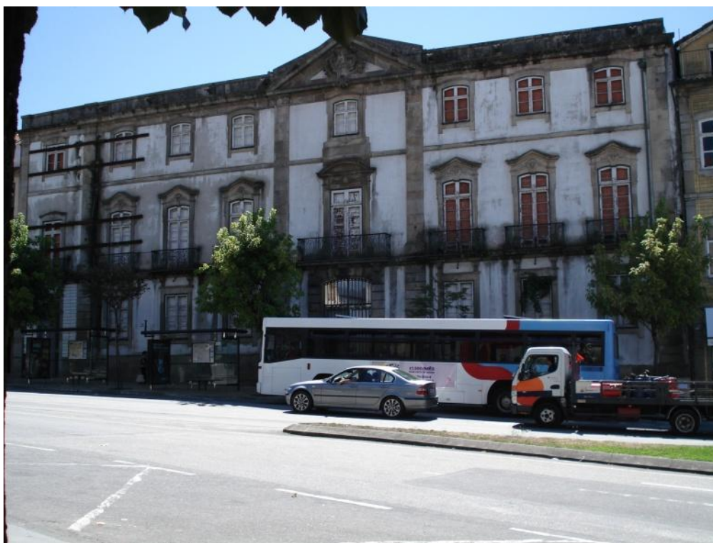
Figura 18:Edifício do Tribunal degradado e destruído no seu interior
