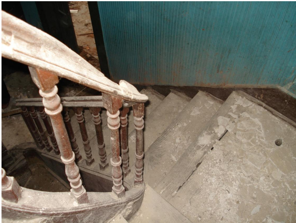
Figura 39 : Escadaria de acesso em madeira, interior do edifício, situação actual
