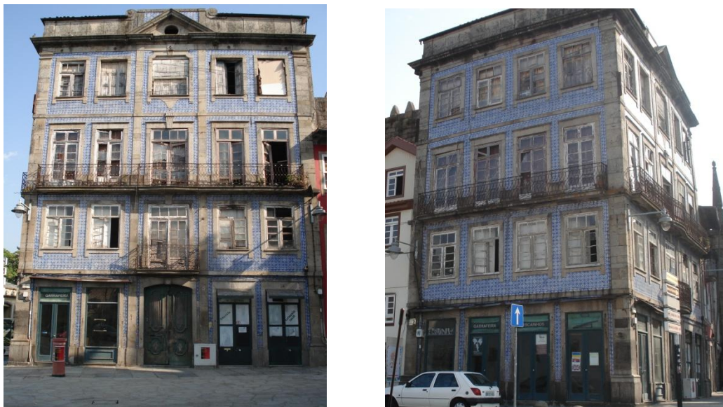
Figura 42: Edifício em estudo para Reabilitação
