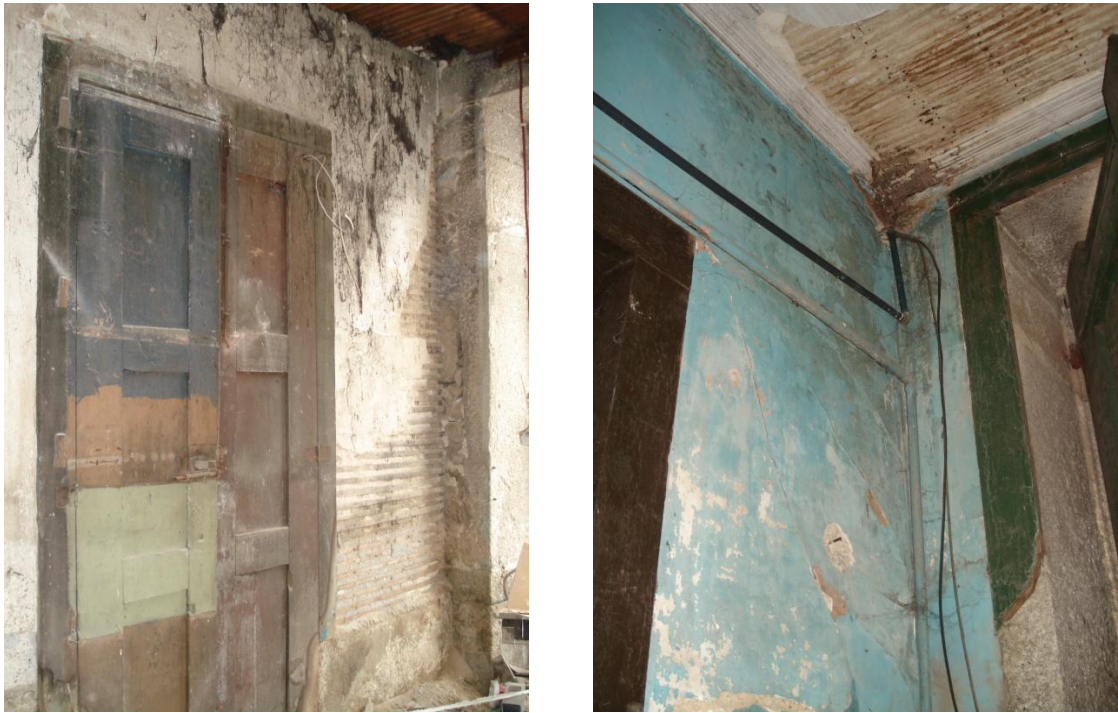
Figura 38: Paredes e Portas interior do edifício, situação actual
