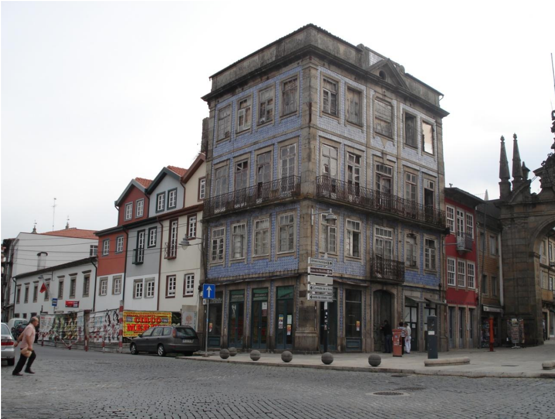
Figura 34: Edifício em estudo para Reabilitação
