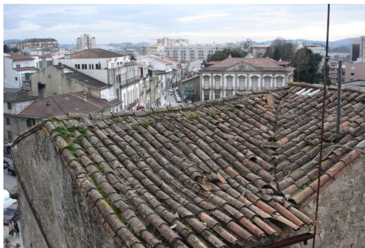
Figura 43: Estado da cobertura do Edifício em estudo para Reabilitação
