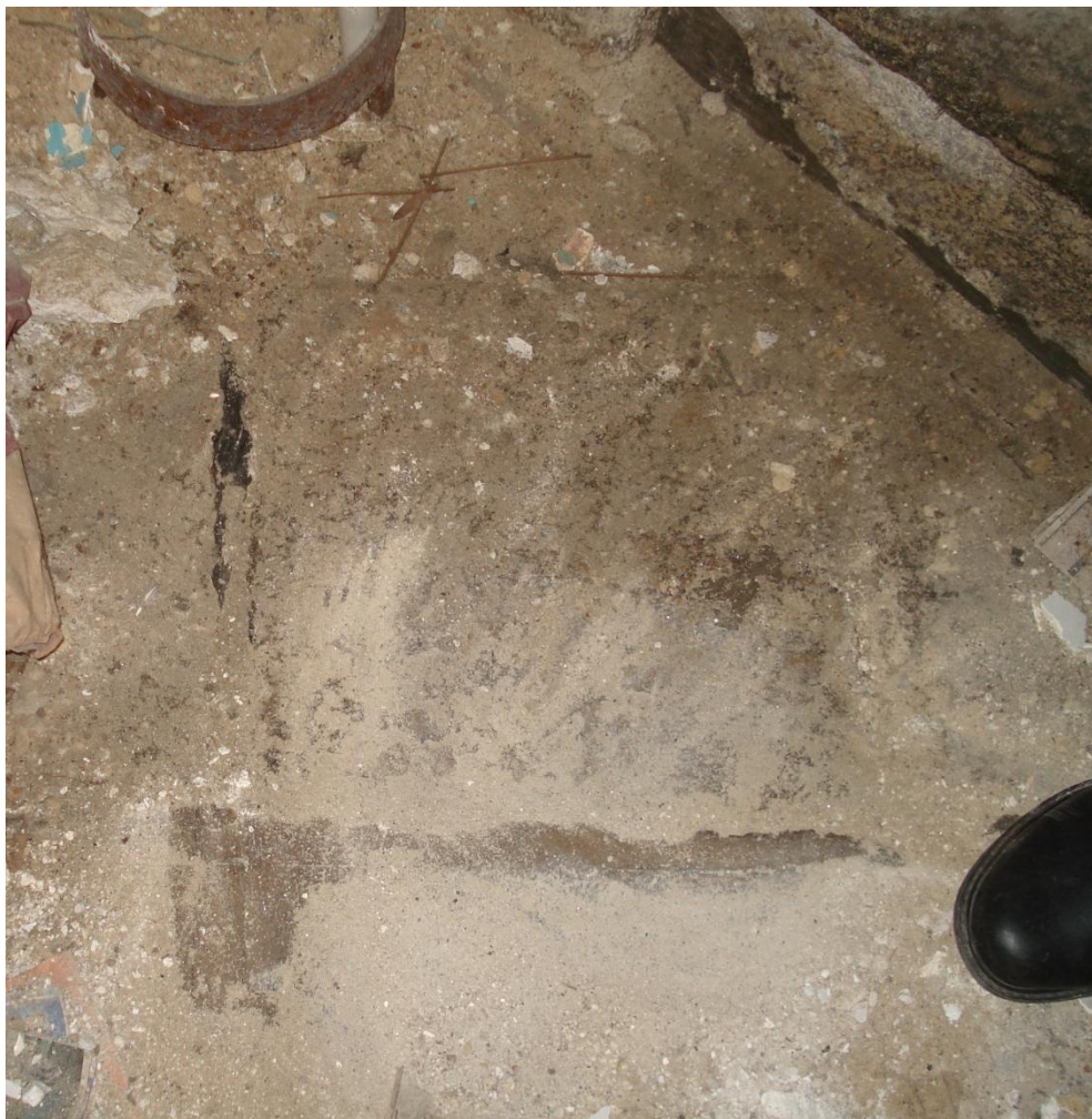
Figura 41: Pavimento pedra do período barroco, situação actual
