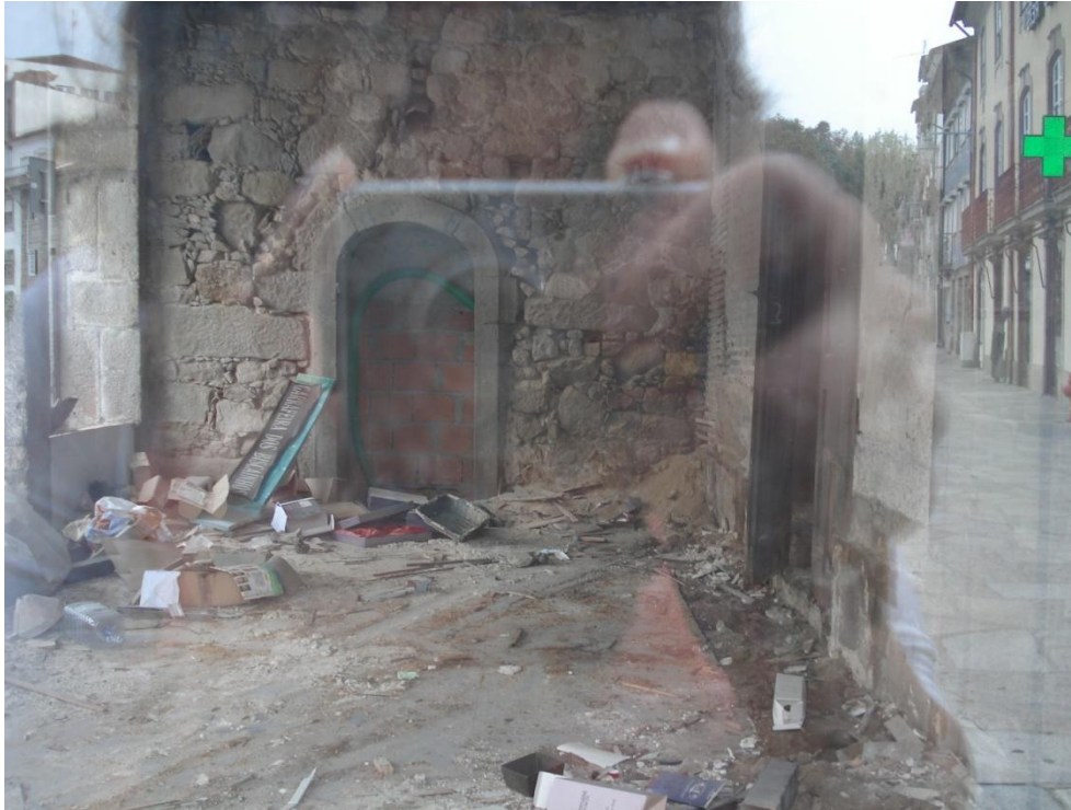
Figura 40: Parte interior da área comercial do edifício, situação actual
