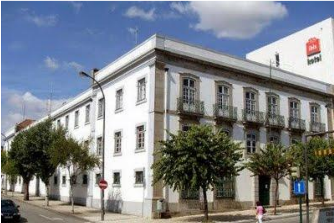
Figura 29:Antigo Edifício da GNR
