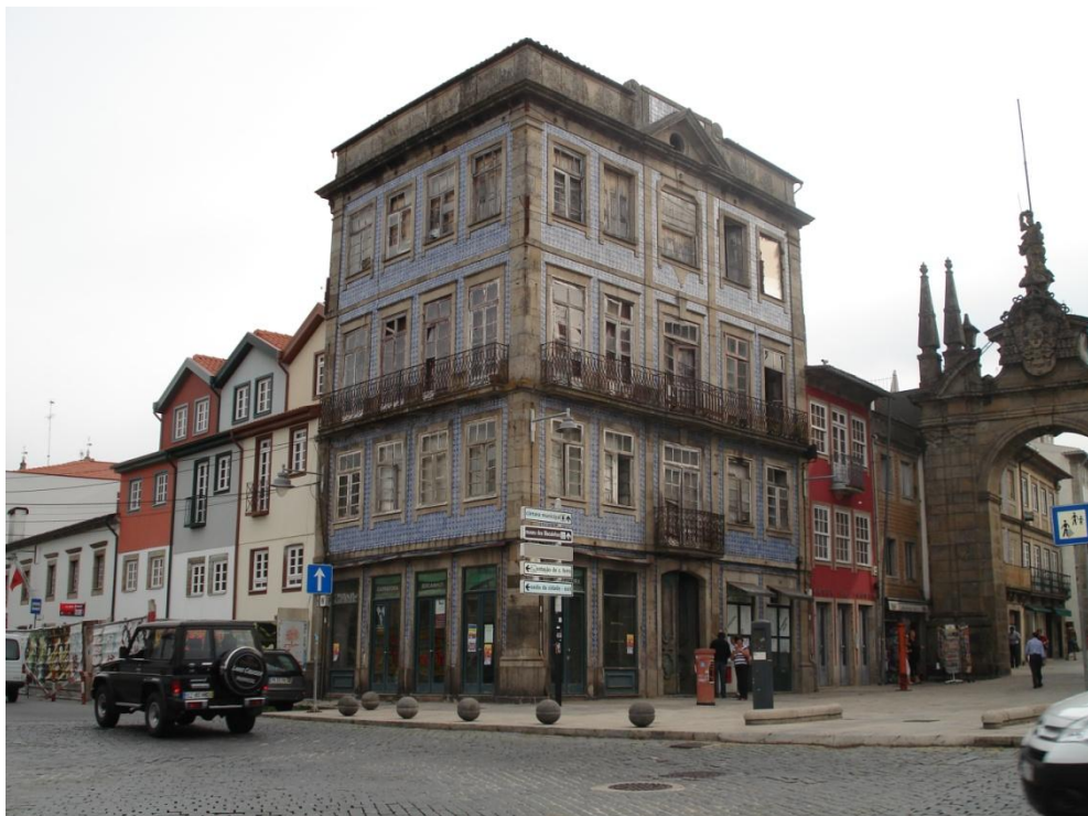
Figura 20: Edifício de gaveto em estudo, ladeado por edifícios reabilitados
