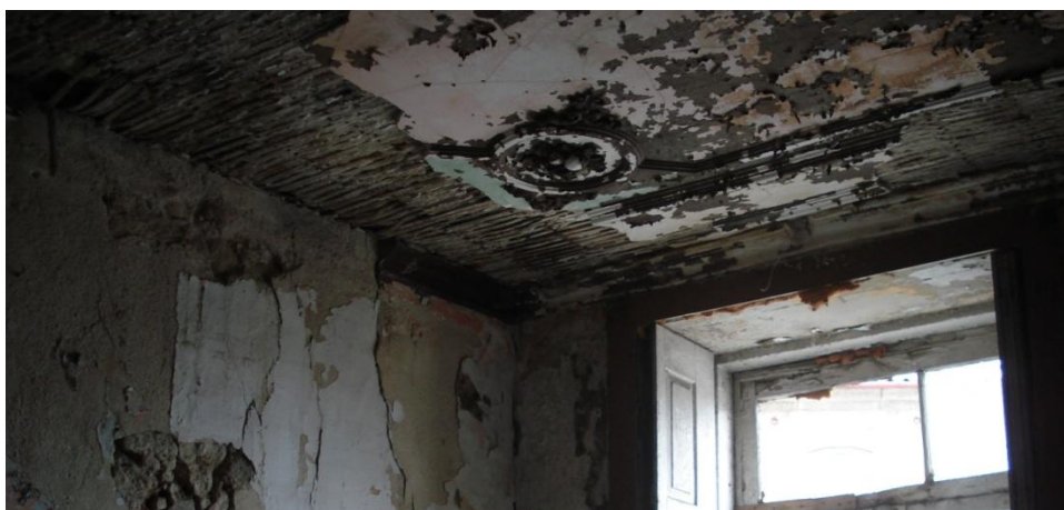
Figura 44: Estado dos elementos interiores do Edifício em estudo para Reabilitação
