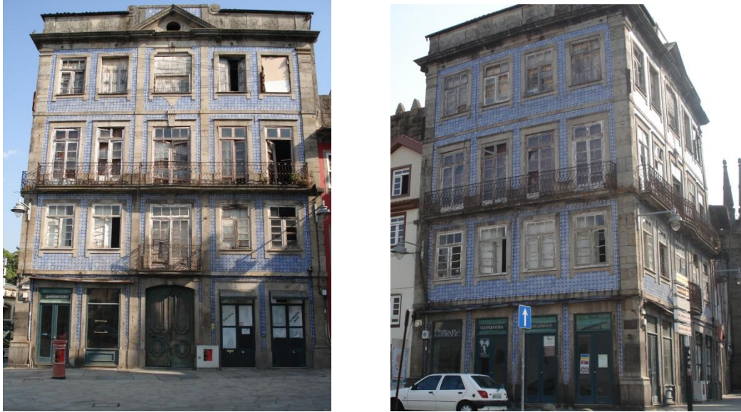
Figura 49: Edifício em estudo para Reabilitação
