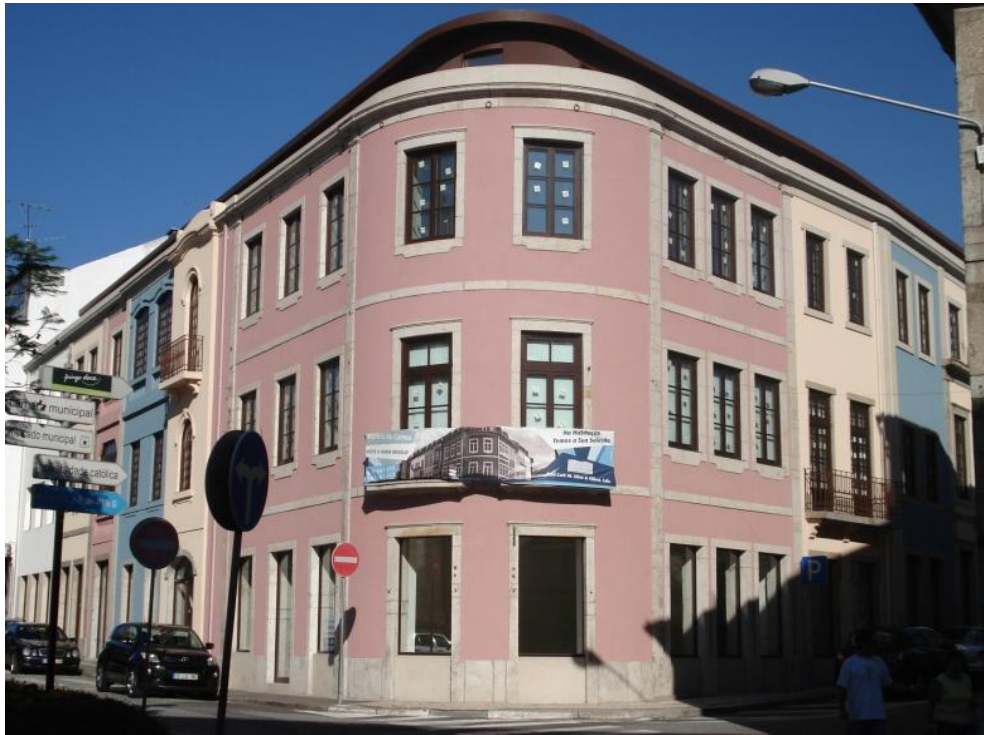
Figura 21:Edifício recentemente recuperado
