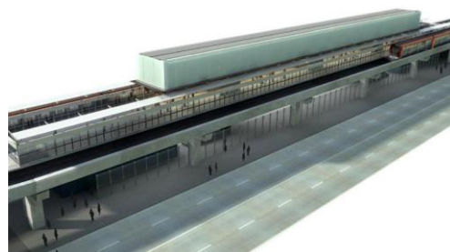
Fig. 14- Estação do tipo viaduto
