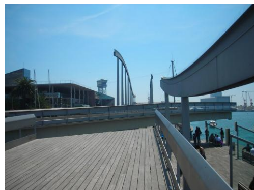
Fig. 135- Abertura da ponte para deixar passar barcos para a marina na Rambla del Mar
