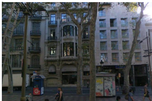
Fig. 122- Fachada em pedra calcária trabalhada de Las Ramblas
