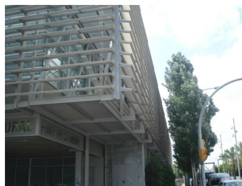
Fig. 173- Pormenor da fachada de um edifício acabado recentemente da Rambla de la Mina
