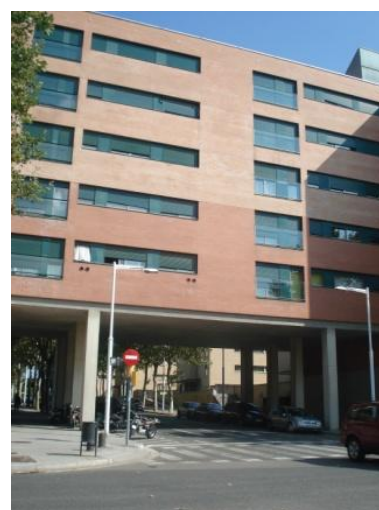
Fig. 179- Fachada da Avinguda d'Icària
