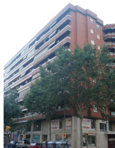
Fig. 164- Edifício em tijolo de burro da Rambla de Guipúscoa
