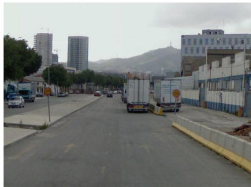
Fig. 6- Carrer de la Metal-lúrgia
