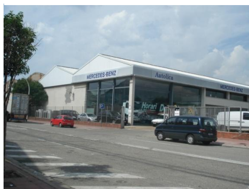
Fig. 52- Armazém do Carrer N° 1: demolir
