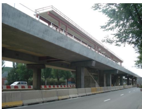
Fig. 19- Estação oficial da Zona Franca Litoral, obras da estação
