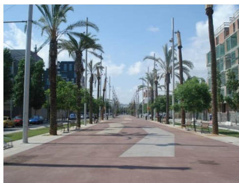
Fig. 168- Corredor pedonal em asfalto colorido da Rambla de la Mina
