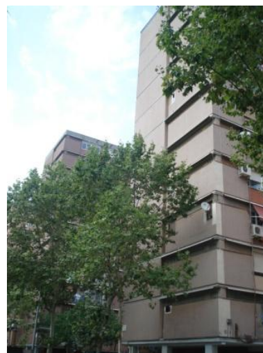
Fig. 156- Fachada lateral com poucos vãos de um edifício em reboco da Rambla de Prim
