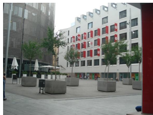
Fig. 130- Novos edifícios da Plaza Vásquez Montalban
