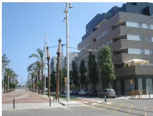
Fig. 171- Edifício em fase de acabamentos na Rambla de la Mina
