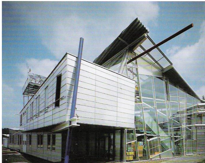
Fig.69 Behnisch & Partner: edifício do Instituto de Investigação Hysolar da Universidade de Estugarda. Estugarda 1987
