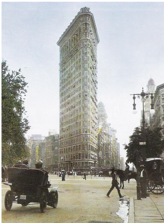
Fig.13 Daniel Hudson Bumham: flat iron (edifício fuller), Nova Iorque 1902. O arranha-céus na Broadway, Implantado num terreno com um ângulo extremamente agudo com a forma de um ferro de engomar (daí o nome) -é considerado exemplar da utilização otimizada de urna área limitada.
