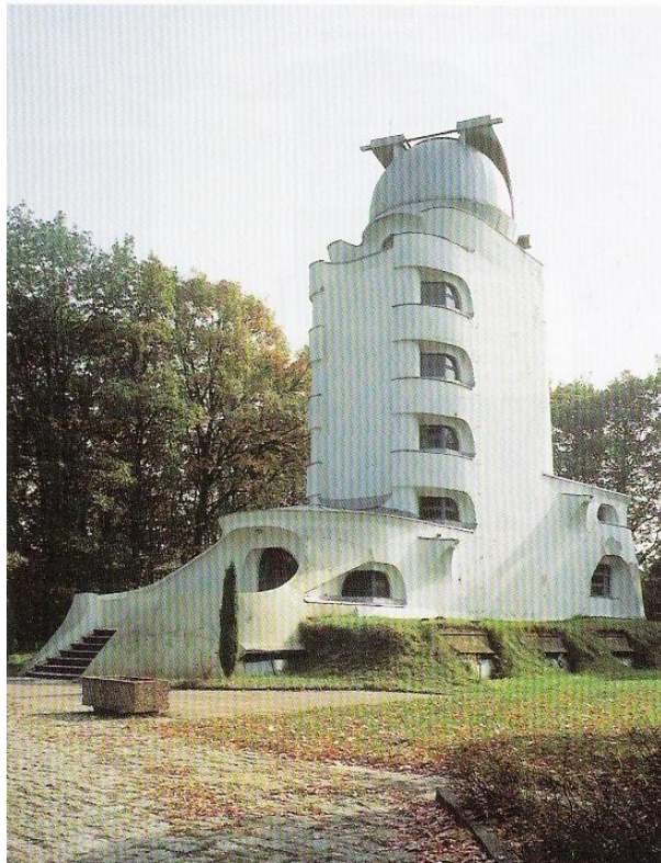
Fig.28 Torre Einstein no Telegrafenberg.,. Potsdam, 1920-21 Fonte: Wikipédia
