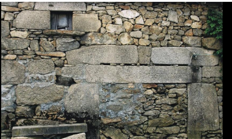
Figura LXXXI - Casa de Granito, Casas de Monforto, Chaves
