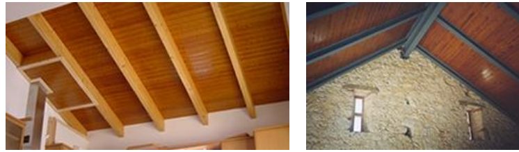
Figura 21. Aplicação de painel sanduíche no interior da cobertura de um edifício (fonte: Onduline)
