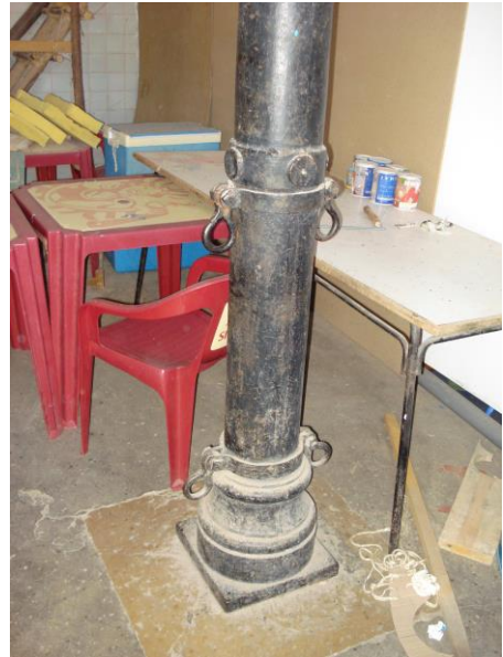
Figura 11. Pilar em ferro (fonte: Inês Peste, 2008)
