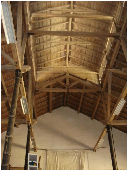
Figura 10. Sistema de asnas da cobertura. (fonte: Inês Peste, 2008)
