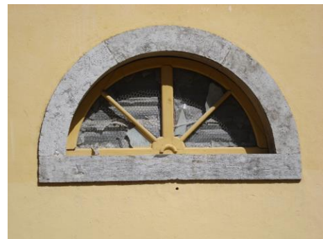
Figura 13. Janela exterior (fonte: Inês Peste, 2008)
