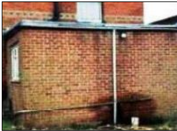
Figura 6 - Drenagem de um Tubo de Queda Diretamente ao Solo - Dias, Luís
