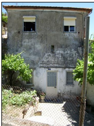
Figura 38 - Fachada do Edifício 2
