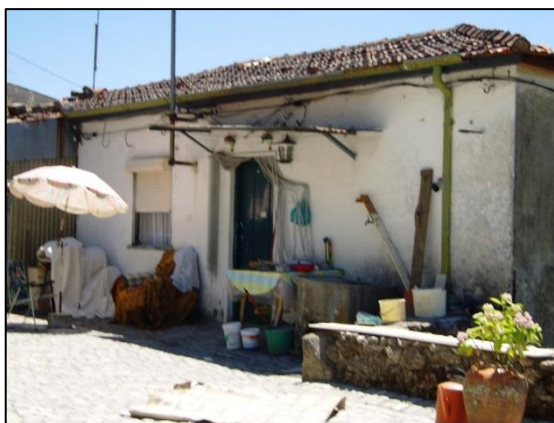
Figura 40 - Fachada do Edifício 3
