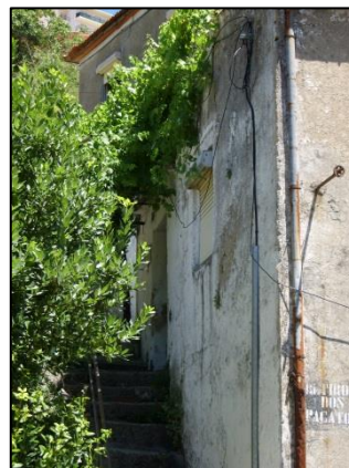
Figura 39 - Fachada do Edifício 1
