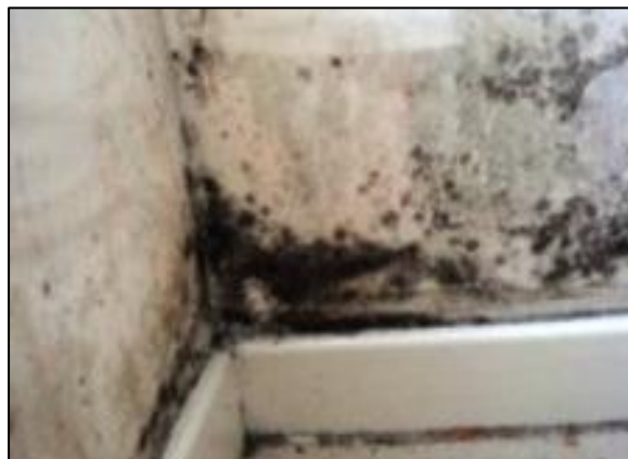
Figura 5 - Humidade Devida à Higroscopicidade dos Materiais - http://valorizacaoimobiliaria.blogspot.pt/2010/12/humidade-ou-condensacao.html
