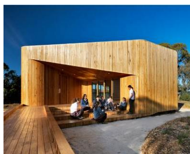
Figura 45 - Zona de Estar Exterior
