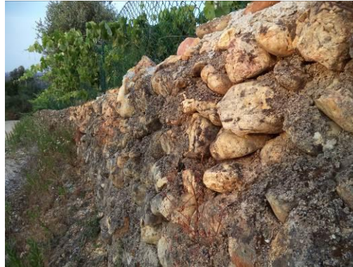
Figura 170 - Muro de Pedra Junto à Habitação nº31
