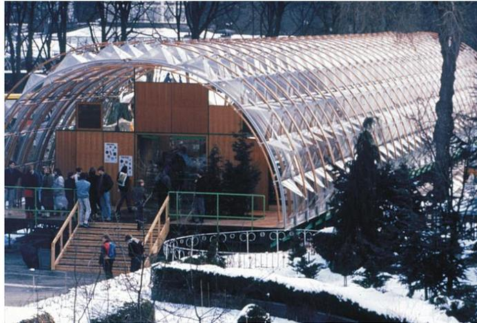
Fig. VIII - Pavilhão IBM de Renzo Piano, pensado como uma série de componentes pré-fabricados para poderem ser desmontados e transportados e remontados. (Fonte: renzopianofondazione.com)
