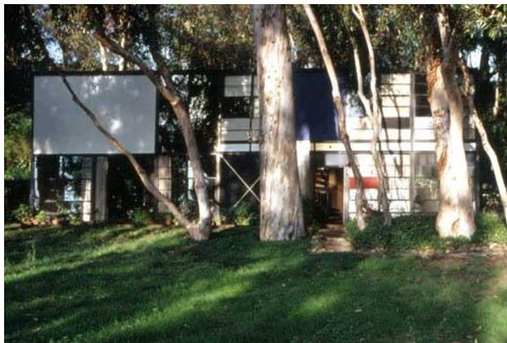
Fig. VII - Casa Eames, desenhada para ser construída com componentes estandarizados comerciais.
