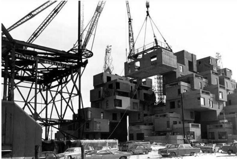
Fig. X - Montagem do Habitat'67 a partir de estruturas modulares. (Safdie 1970)
