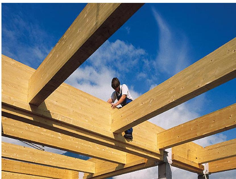
Fig. XXXV - Montagem de Madeira Laminada Colada (fonte: Buildipedia)
