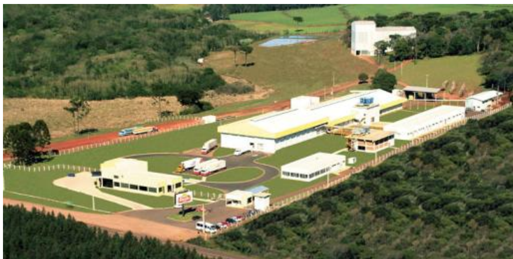
Figura 4 - Empresa Bondio Alimentos S.A., Santa Catarina - Janeiro/2005 Fonte: Bondio Alimentos S.A.
