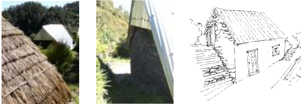
Fig.64 – Aplicação de zinco sobre a cobertura de palha
