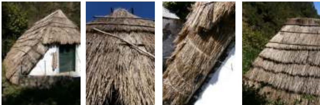
Fig. 63 – Cobertura de palha – Franja.
