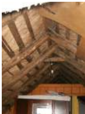
Fig. 48 – Palha à vista no interior do volume 2.
