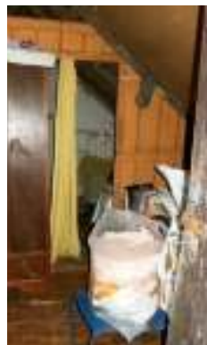
Fig. 49- Paredes divisórias de madeira.
