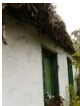
Fig. 15 – Reboco aplicado no volume dos quartos de dormir.
