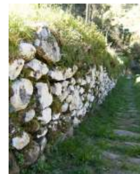
Fig.11 – Muros/socalcos empedrados
