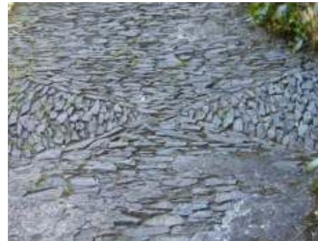
Fig. 24 – Pavimento em pedra irregular a formar desenhos geométricos.
