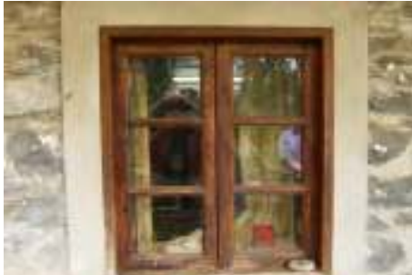
Fig. 73 – Janela da cozinha.
