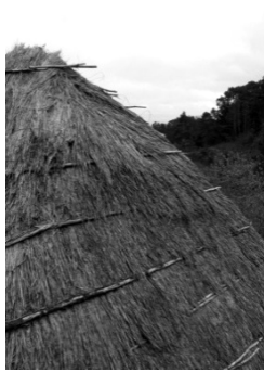
Fig. 70 – Cobertura de palha com quatro águas.
