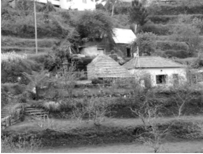
Fig. 67 – Cozinha – Vista da via pública.
