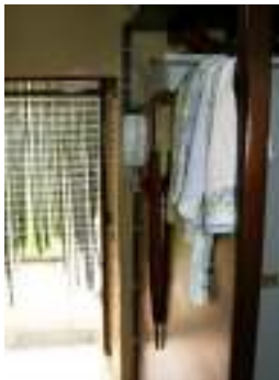
Fig. 69 – Interior da cozinha – Parede divisória.
