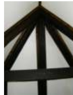
Fig. 58 – Aplicação de forro sobre a palha.
