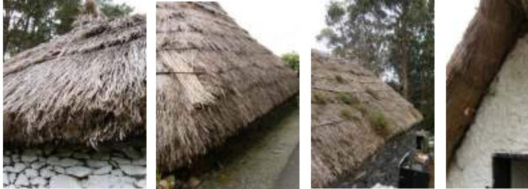
Fig. 46 – Cobertura de colmo.
