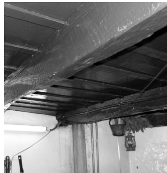
a) Tabuado que separa os pisos.
