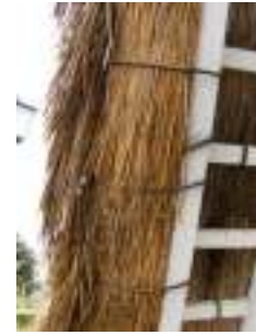
Fig. 31 – Fixação da palha com vime preto.
