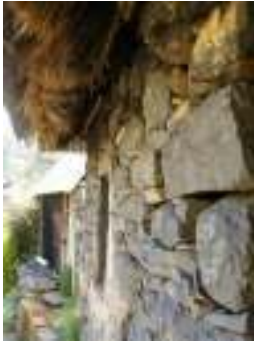
Fig. 12 – Alvenaria de pedra à vista – cozinha.
