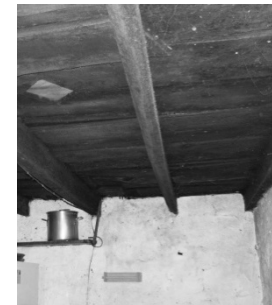
Fig. 38 – Tabuado que separa a cozinha dos arrumos.
