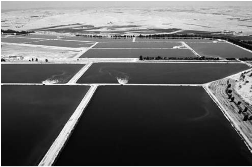
Figura 7-9 – Sistema de lagunagem
